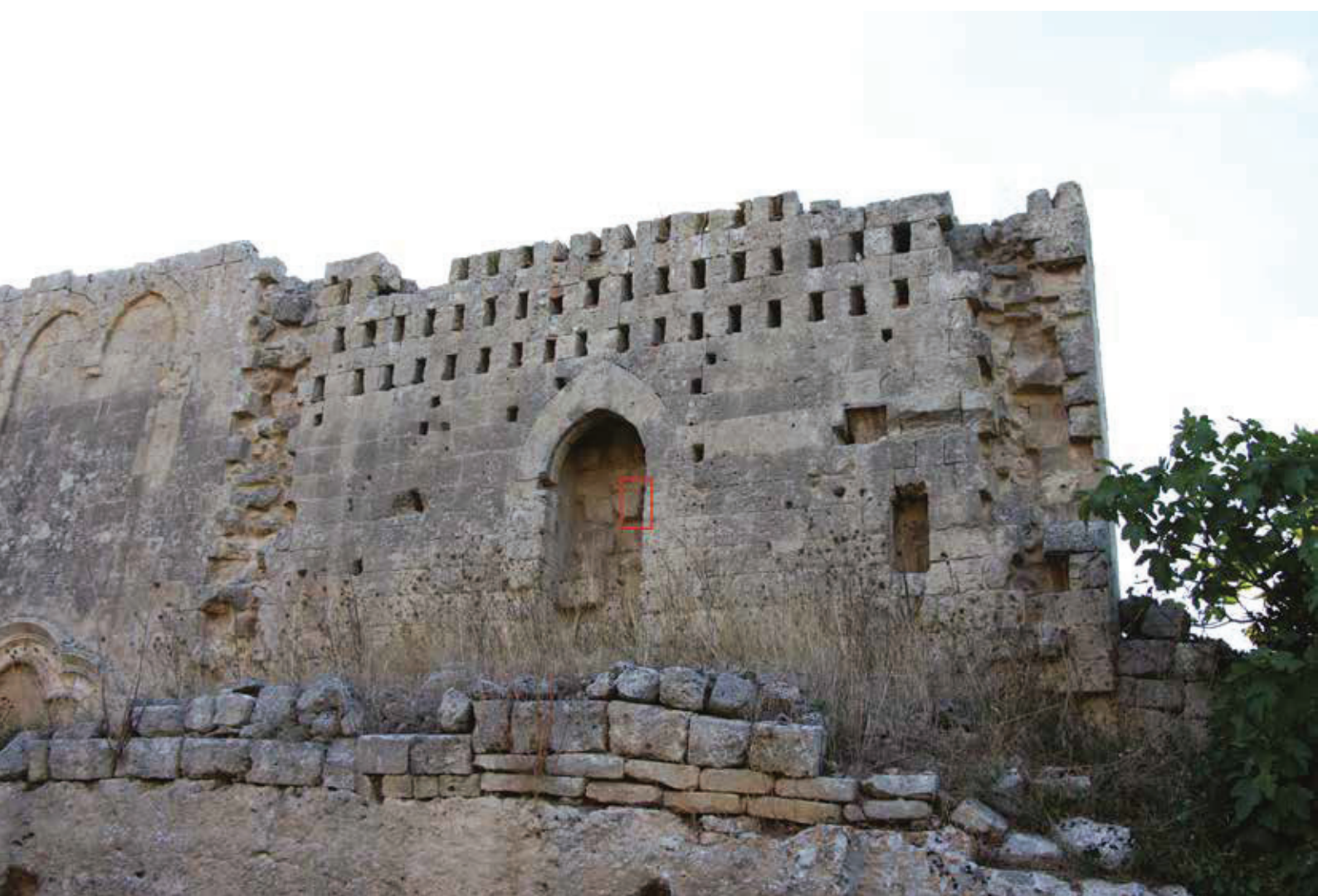
Fig. 7 - Localizzazione del graffito, nell'intradosso destro del fornice (foto S. Centonze)
