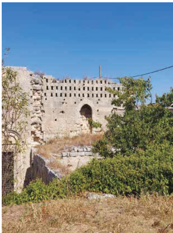
Fig. 4 - Resti del corpo orientale esterno della chiesa rupestre, identificato come campanile; si distinguono il fornice ogivale tamponato e le tre file di cavità pertinenti alle cellette della colombaia (foto S. Centonze)
