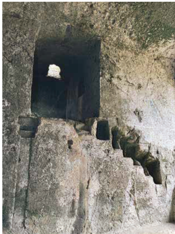
Fig. 6 - Lato orientale della chiesa, con le cavità rettangolari praticate nel banco roccioso, interpretabili come gli alloggiamenti dei gradini di una scala, oggi perduta, che conduceva al piccolo vano sopraelevato, identificabile come pulpito o coro rupestre connesso al sistema campanario. Sul lato aperto verso la navata sporgeva un pianerottolo sostenuto da colonne, delle quali restano nella roccia le impronte dei fusti verticali e dei capitelli (foto S. Centonze)
