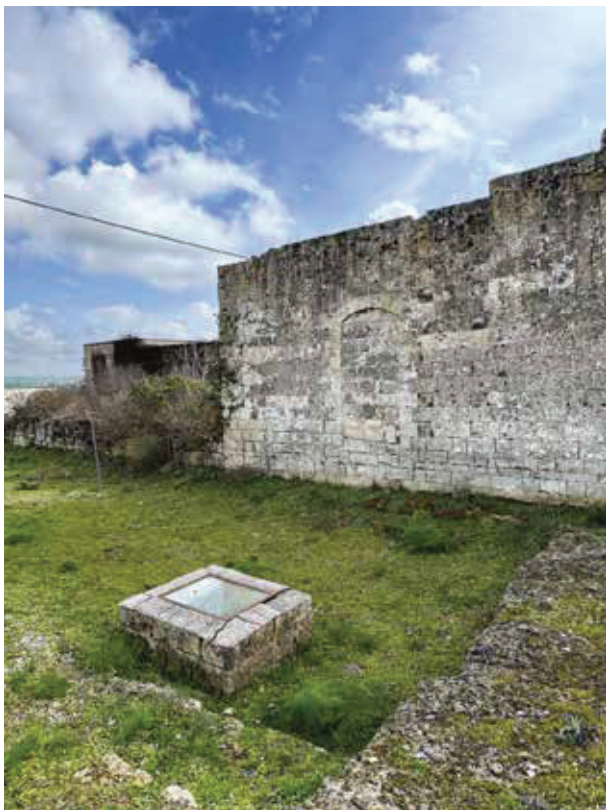
Fig. 5 - Area retrostante il prospetto del campanile, dove si conserva un'apertura ad arco ribassato, in asse con il fornice anteriore e anch'essa tamponata. Sul banco roccioso è ancora leggibile l'impronta quadrangolare della pianta del campanile. Il moderno lucernario vetrato chiude il foro del vano inferiore scavato, consentendone l'individuazione e mettendo in evidenza il collegamento originario tra l'ambiente interno e il volume campanario esterno (foto S. Centonze)
