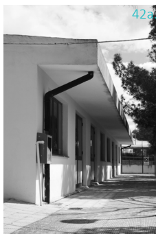
Fig. 42a. Foto. Vista del fronte (sud) della scuola elementare e media. 2025.
