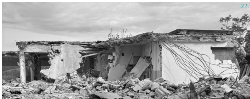
Fig. 22. Foto. Demolizione dell'ex asilo nido di Accettura. 2025.
