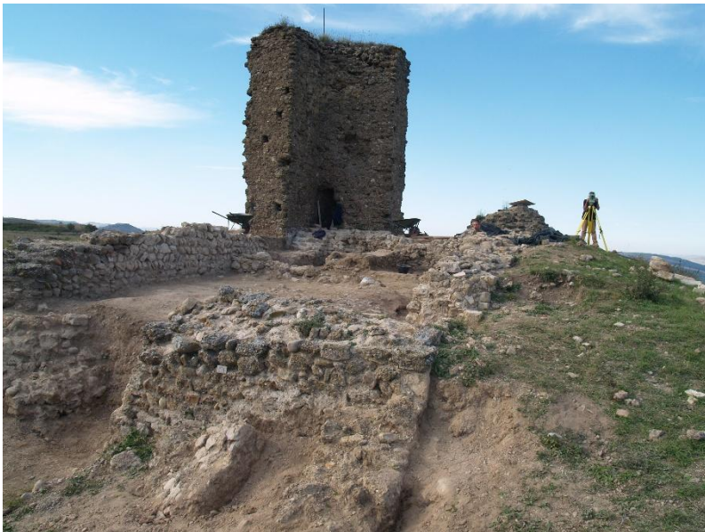
Fig. 8. In primo piano l'edificio del "torrazzo" e sullo sfondo la struttura a L (Archivio SSBA Unibas).
