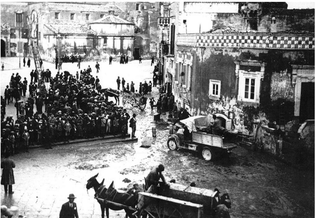
3: Associazione MUV Matera, Accumulo di detriti e fango in Piazza Vittorio Veneto in occasione dell'alluvione del 1928, 1928.
