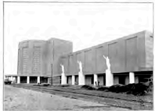
Padiglione Italia - Esposizione internazionale di Liegi 1930 interamente rivestito di MafTex per 10.000 mq. - Progetto degli Ingg. arch. G. Pagano-Pogatschnig e G. Levi-Montalcini
