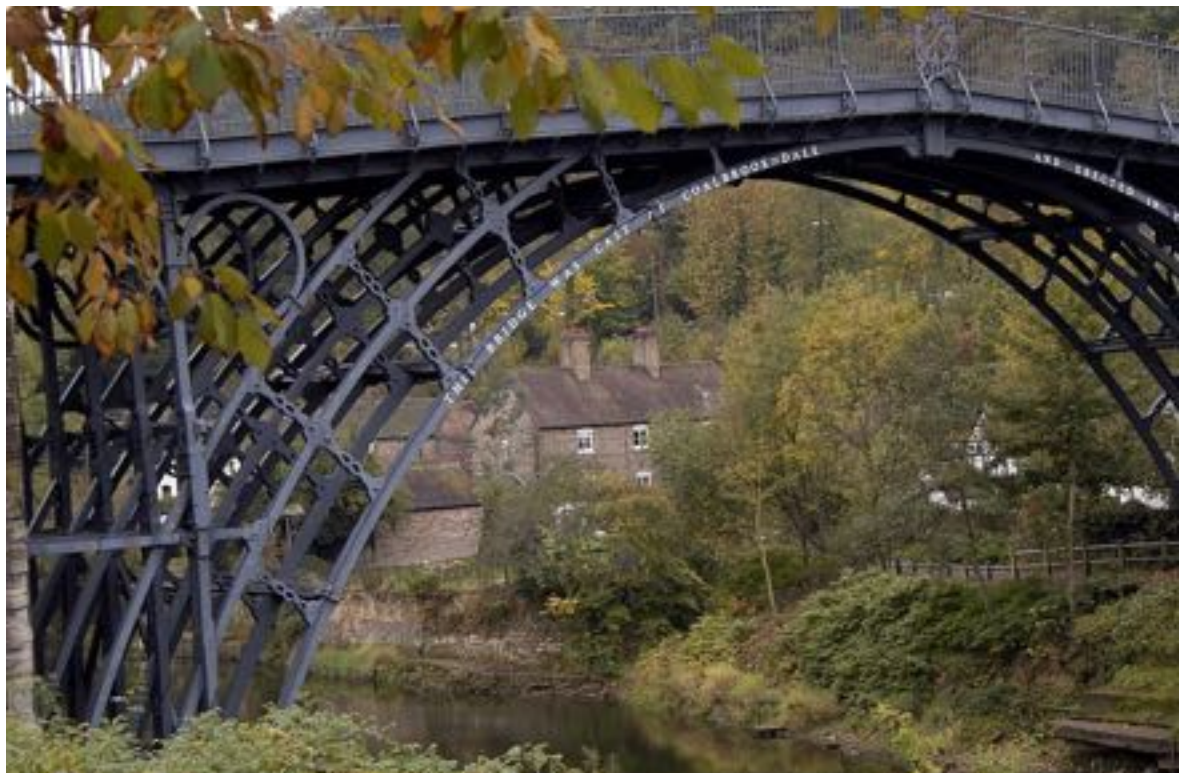
Fig.1 | Ponte "Iron Bridge" detto anche "Ponte sul fiume Severn", 1779-1781, Abraham Derby, campata da 30m.
