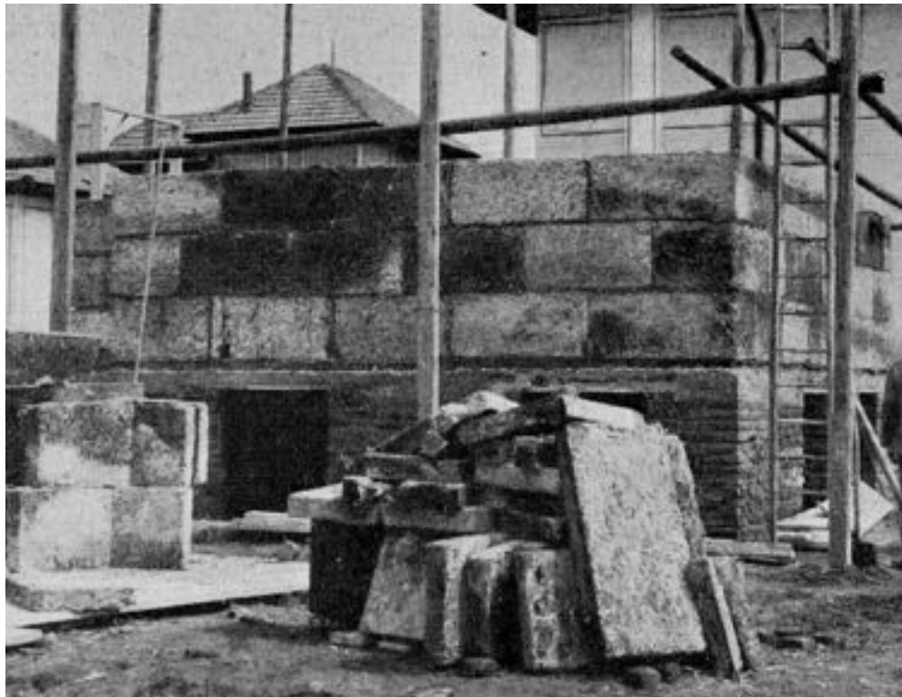
Fig.5 | Immagine storica di una costruzione realizzata in blocchi di Magnesilite, in Griffini E., "Costruzione razionale della casa", Hoepli Ed., Milano, 1932, pag.90.
