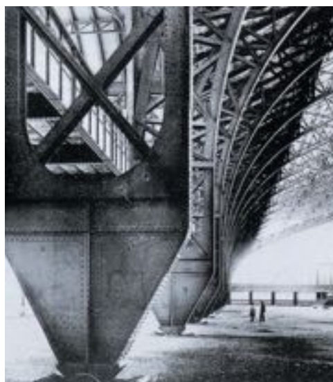
Fig.4 | La Galerie des Machines 1889 è tra gli esempi più arditi di costruzioni in ghisa con elementi reticolari. Tale fabbrica fu realizzata interamente con elementi prefabbricati in ghisa e montati direttamente in cantiere.
