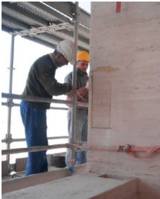
Fig.24 | Immagine di cantiere per il trattamento della superficie lapidea del Palazzo della Civiltà Italiana nel quartiere EUR di Roma (rif. https://www.kimia.it/it/referenze/palazzo-della-civiltà-italiana ).
