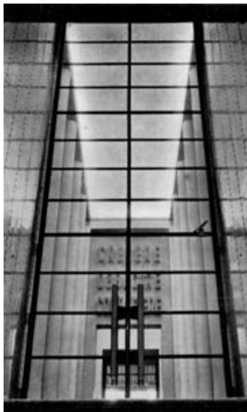
Fig.116 | Foto storica dell'interno della mostra; in evidenza il rivestimento di lamiera di alluminio bulinato della Mostra della Rivoluzione Fascista, Roma, 1932.
