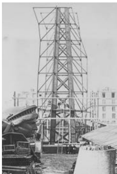
Fig.10 | Fase di montaggio della statua della Libertà, opera di Gustave Eiffel e Auguste Bartholdi, 1875, New York.
