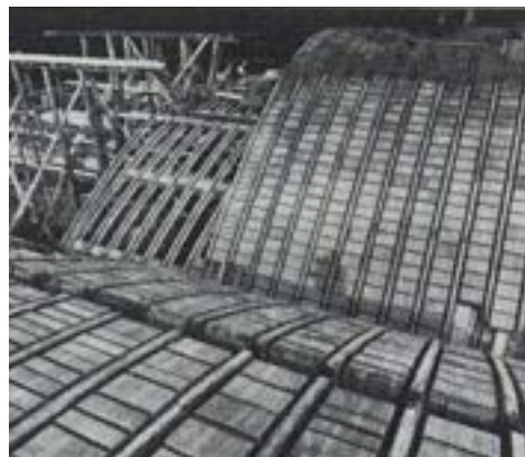
Fig.01 | A sinistra: elementi in laterizio con travetti in calcestruzzo armato costituenti il sistema voltato prefabbricato. A destra: fase di cantiere per il montaggio del sistema voltato (rif. Astrua G., "Manuale completo del capomastro assistente edile", Hoepli Editore, Milano, 1995).
