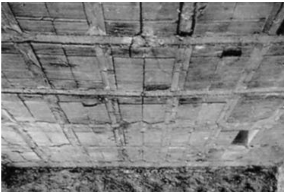
Fig.50 | Prova di carico su un solaio De Simone di 5,1m x 6,0m. Si noti la rottura in mezzeria con carico di 1500kg/m 2 .
