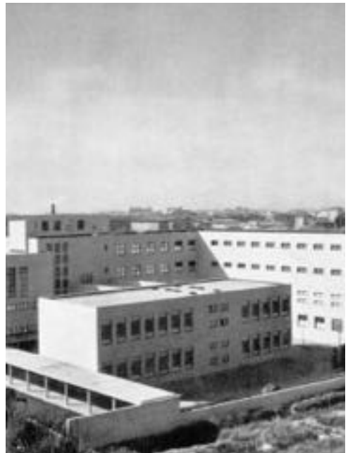
Fig.81 | Vista d'insieme dell'Università commerciale Bocconi, progetto degli architetti Giuseppe Pagano e Giangiacomo Predeval, Milano, 1937-1942.
