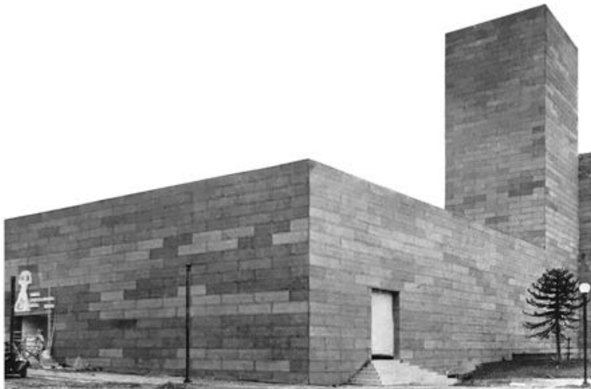
Fig.1 | Padiglione della mostra di Agricoltura di Bologna, 1935, in "ERACLIT, PIASTRE LEGGERE PER L'EDILIZIA E RIVESTIMENTI ISOLANTI", Gennaio e Febbraio 1936, Eraclit Vernier S.A. - Portomaghera, Venezia, pag.5.
