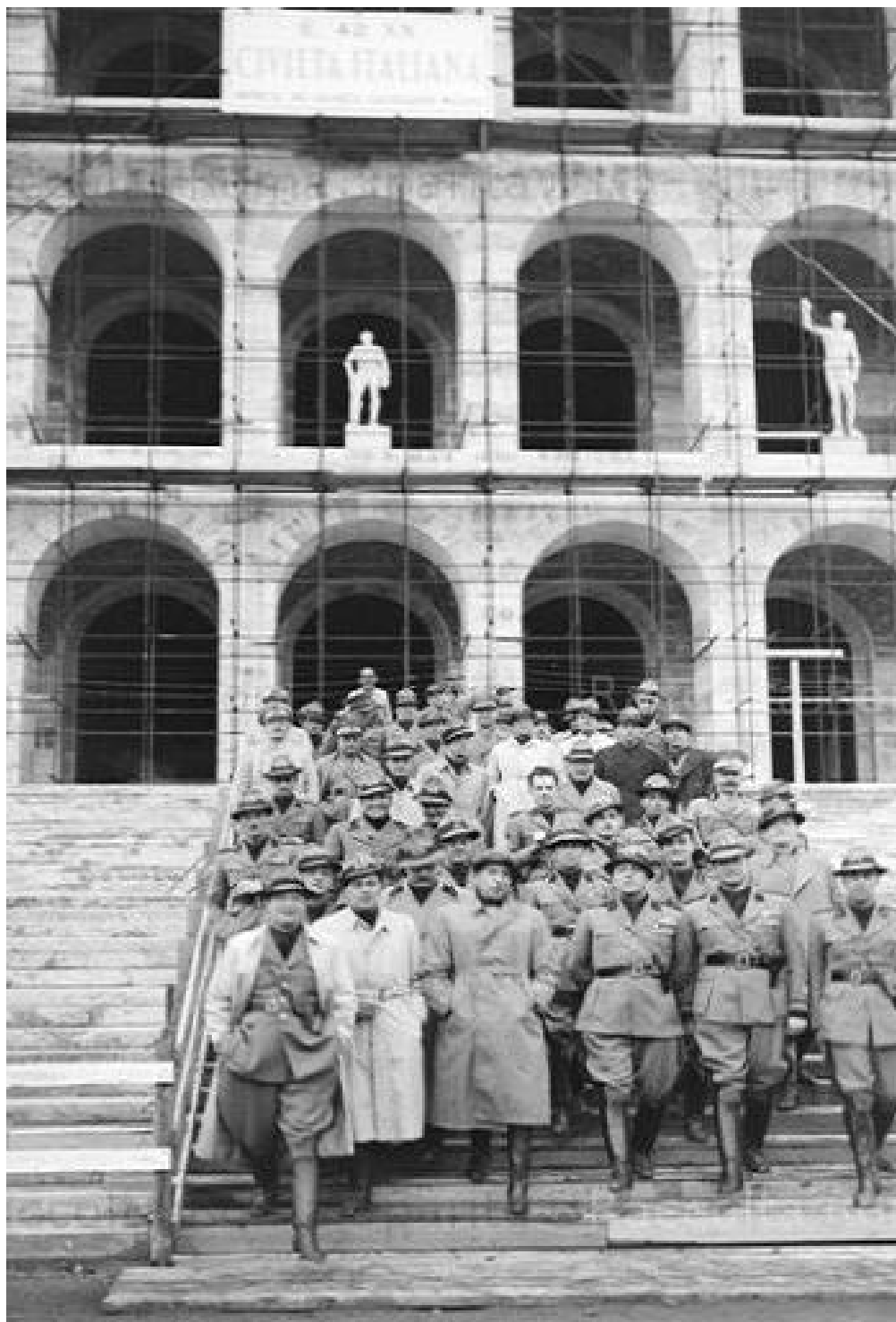
Fig.02 | Foto storica delle fasi costruttive del cantiere del Palazzo della Civiltà Italiana, progetto di Giovanni Guerrini, Ernesto Bruno Lapadula, Mario Romano, Roma, 1938-43.
