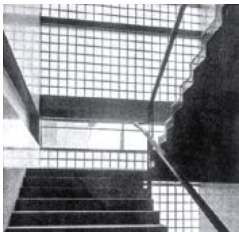
Fig.24 | Vista interna della scala principale della Casa del Fascio a Como. Sistema di vetrocemento costituito da diffusori in vetro a formare una parete continua vetrata, interrotta da infissi con profili in acciaio.
