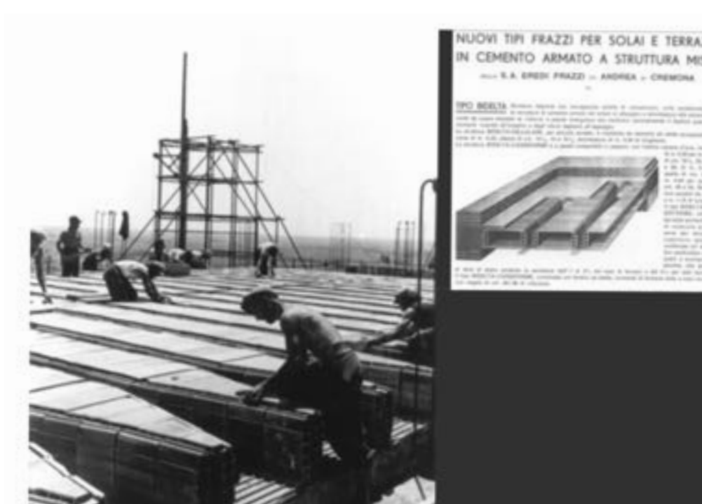
Fig.06 | In alto: realizzazione della volta del loggiato a un foglio di laterizio. In basso: immagine storica del cantiere per la realizzazione del solaio tipo "Bidelta".
