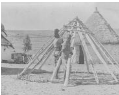
Fig.34 | Foto storica della costruzione di una abitazione Tukul in Eritrea, Asmara.
