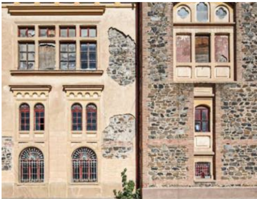
Fig.95 | Prospetto laterale del Teatro Asmara; si evincono i diversi tipi di materiale di origine locale adoperati nella costruzione. Blocchi di basalto combinati con mattoni ed elementi in calcestruzzo armato intorno alle aperture. Una fascia di intonaco alla base dell'edificio nasconde i blocchi di basalto più grandi usati per la realizzazione delle fondazioni evitando l'umidità di risalita.
