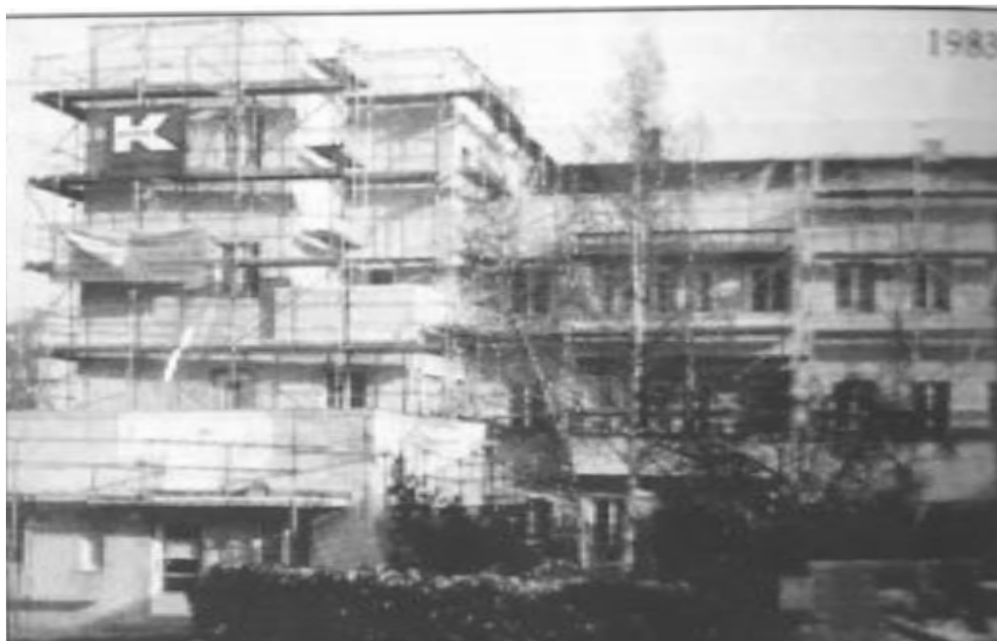
Fig.15 | Foto storica della fase di cantiere di restauro di casa Oud al Weissenhof di Stoccarda, prospetto nord, foto di Marco Dezzi Bardeschi.
