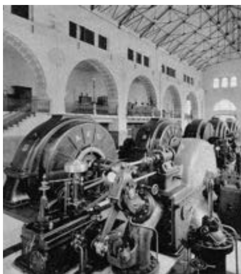
Fig.7 | Cartolina con alcuni apparecchi meccanici per la produzione di energia elettrica, nella centrale dell'Aniene (Lazio).
