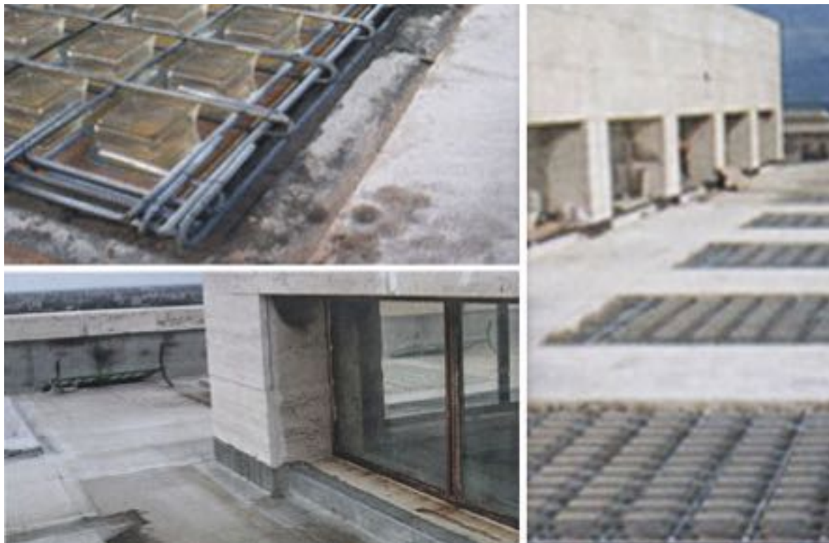
Fig.23 | Immagini di cantiere del restauro del Palazzo della Civiltà Italiana nel quartiere EUR di Roma.
