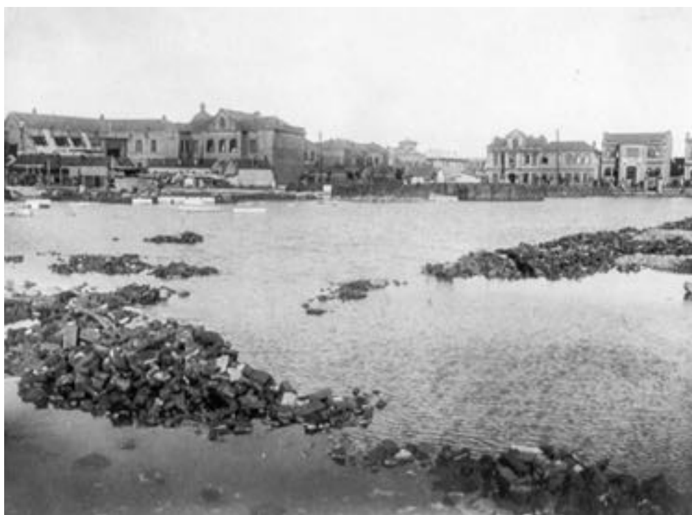
Fig.23 | Lavori di bonifica dell'area del cantiere dell'ospedale della Concessione Italiana a Tianjin (rif. Archivio fotografico di G. L. Arnaud).
