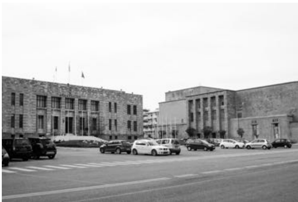
Fig.6 | Casa del Fascio di Rodi, progetto dell'architetto Florestano Di Fausto, 1925.
