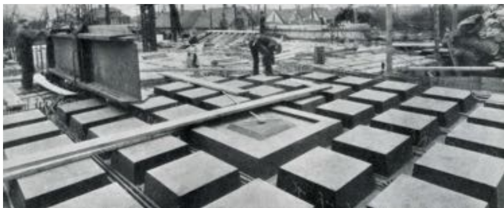
Fig.01 | Immagine storica di un cantiere per la realizzazione di un solaio con elementi di alleggerimento in "Masonite" (rif. E. Griffini, "La Costruzione Razionale della Casa" , IV Edizione, Hoepli, Milano, 1948).
