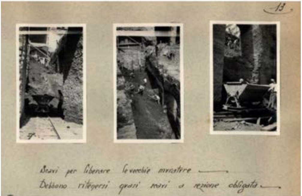
Fig.02 | Foto storiche di cantiere del Palazzo delle Poste di Napoli, in Alfonso Morone, "La fabbrica dell'innovazione - gli arredi del Palazzo delle Poste - Napoli, 1936", Napoli, 2017.
