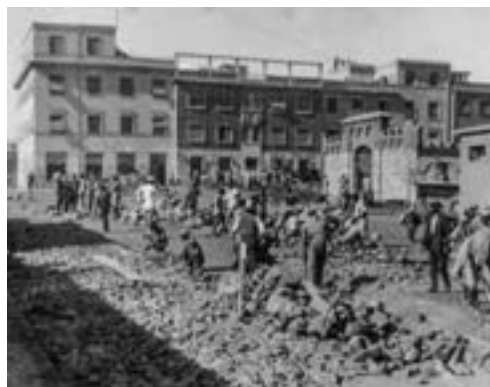
Fig.91 | Operai eritrei e italiani che posano blocchi di basalto per la realizzazione del manto stradale delle nuove strade del centro di Asmara.
