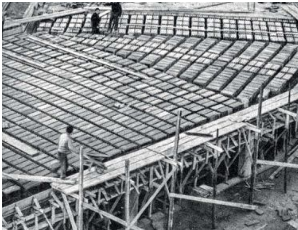
Fig.43 | Montaggio di un solaio Stimp, in rivista "Il Laterizio" bollettino periodico Erredibi n.7, aprile 1951, Piacenza.
