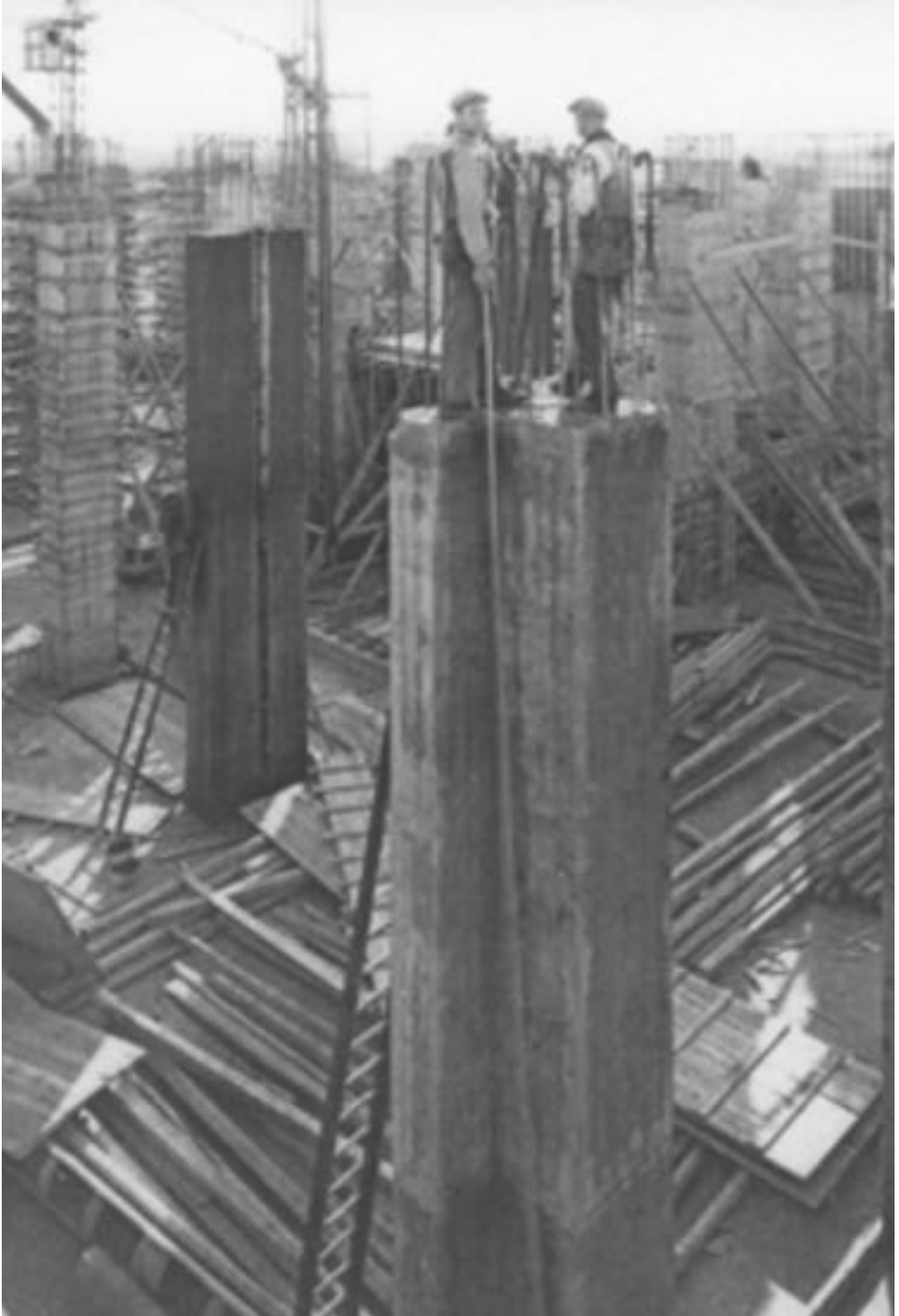
Fig.11 | Foto storica delle fasi costruttive del telaio in c.a. del Palazzo della Civiltà Italiana, progetto di Giovanni Guerrini, Ernesto Bruno Lapadula, Mario Romano, Roma, 1938-43.
