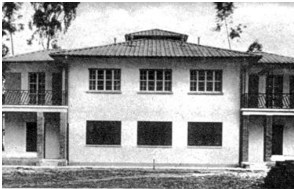
Fig.66 | Foto storica di un villino residenziale realizzato dall'INCIS, denominato "tipo 6 con quattro alloggi", Addis Abeba, 1932.
