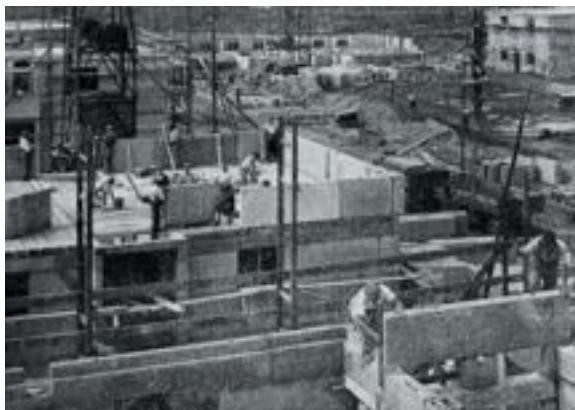
Fig.01 | A sinistra: sezione di un sistema tipo "Frank". A destra: foto storica di un cantiere con la realizzazione del sistema in pietra pomice (rif.E. Griffini, "La Costruzione Razionale della Casa" , IV Edizione, Hoepli, Milano, 1948).
