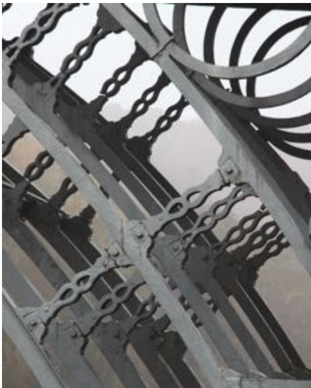
Fig.2 | Particolare costruttivo del Ponte sul fiume Severn. Si noti che non è presente nessuna unione bullonata tra gli elementi strutturali. Per la realizzazione sono state sfruttate le sole tecniche allora conosciute della carpenteria ovvero incastri a coda di rondine tra gli elementi. Si consideri che la trave più grande pesa oltre le 5 tonnellate.
