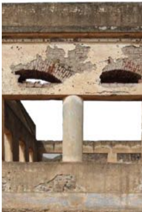
Fig.86 | Rudere di un ex impianto di lavorazione dell'acqua tra Asmara e Massaua, rivela le tecniche costruttive e i materiali locali celati dietro un aspetto in stile modernista.
