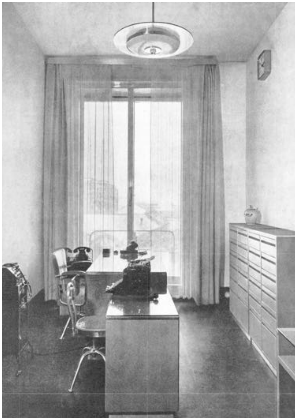
Fig.109 | Foto storica dell'interno di un ufficio con pavimento in "Linoleum" color bruno, pareti tinteggiate in "Duco" nocciola chiaro, mobili eseguiti dalla ditta Antonio Parma in metallo verniciato color nocciola, guarnizioni in alluminio; piano in "Cristallo Securit" e coperture in cuoio rosso. Palazzo Montecatini, progetto degli architetti Giò Ponti, Antonio Fornaroli ed Eugenio Sencini, Milano, 1936 (in "Domus", n.135, 1939, pag.37).
