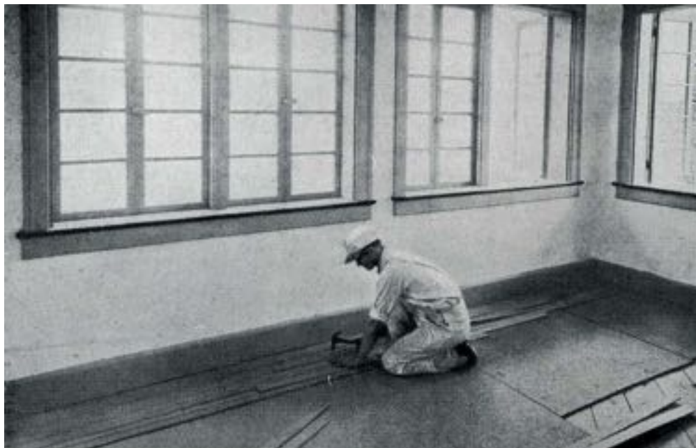
Fig.125 | Il Celotex (variante Linobase) utilizzato come sottopavimento, in Griffini E., "Costruzione razionale della casa", Hoepli Ed., Milano, 1952, pag.74
