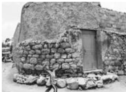
Fig.92 | Prime soluzioni abitative in materiale locale a pochi chilometri da Asmara, costituite da elementi di granito.
