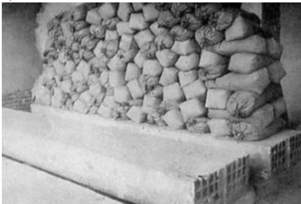
Fig.49 | Prova di carico su un componente di un solaio Neumann, lunghezza 4,6m.
