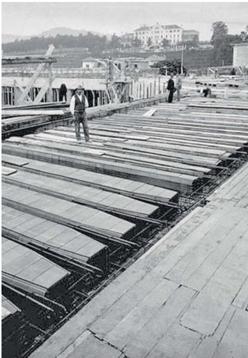
Fig.16 | Immagine storica del cantiere per la realizzazione del solaio tipo "Bidelta".
