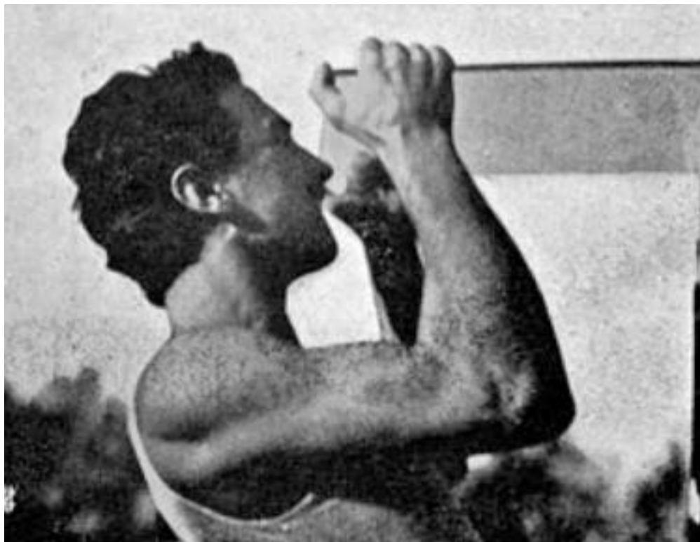
Fig.89 | Prova pratica della resistenza a flessione di un vetro infrangibile, in "DOMUS", n.61, Gennaio 1933, pag.51.
