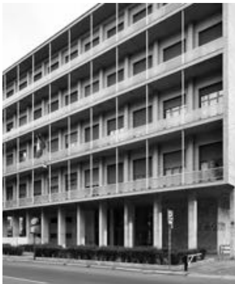
Fig.78 | Università commerciale Bocconi, progetto degli architetti Giuseppe Pagano e Giangiacomo Predeval, Milano, 1937-1942.
