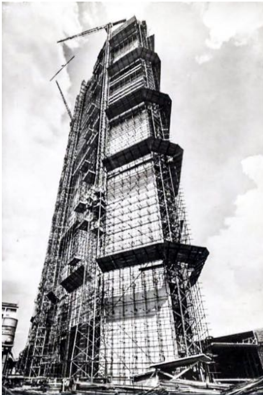
Fig.22 | Immagine storica della costruzione del Grattacielo Pirelli, progetto dell'architetto Gio Ponti, 1956-1960.
