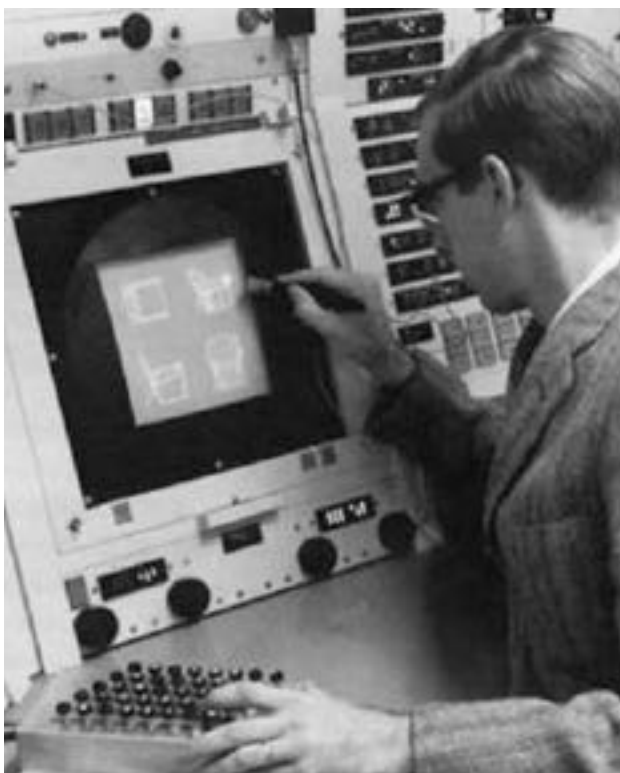
Fig.2 | Immagine storica di Ivan Sutherland intento a testare uno dei primi software "CAD" sul sistema "MIT TX-2": "Sketchpad", 1962.
