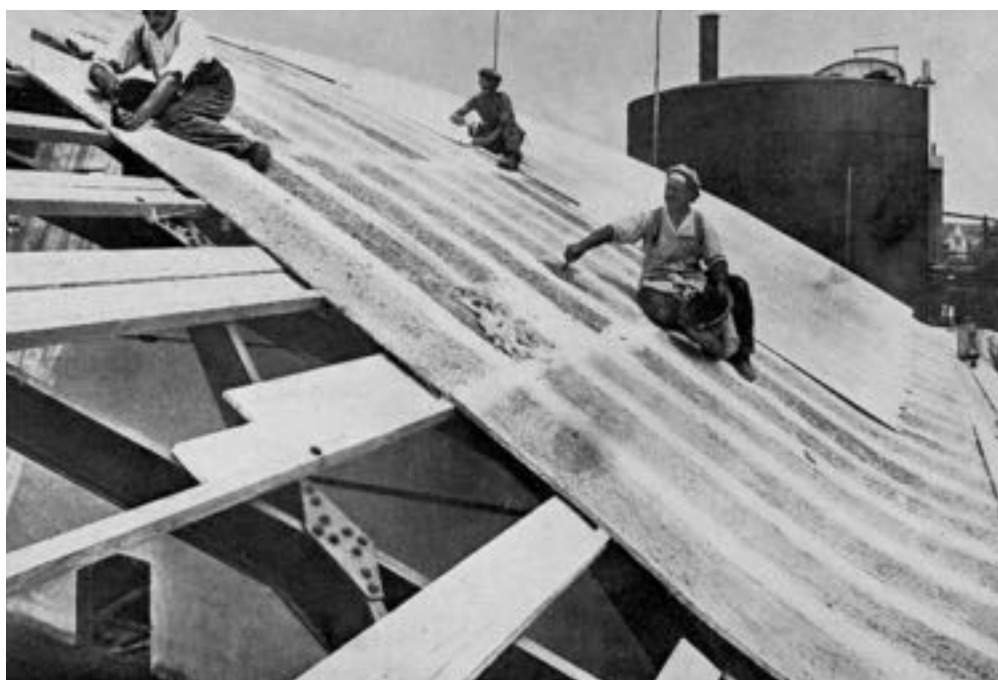
Fig.114 | Immagine storica della posa in opera di lastre in Eraclit per l'isolamento termoacustico delle coperture, in "DOMUS" n.60, Dicembre 1932, pag.106
