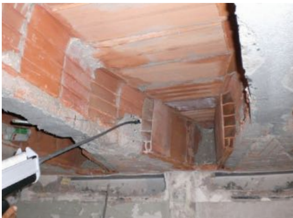
Fig.07 | Immagini del cantiere di restauro del Palazzo della Civiltà. Solaio tipo "Bidelta".
