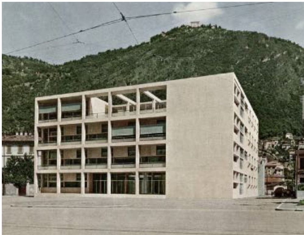
Fig.96 | Foto storica della Casa del Fascio, progetto dell'architetto Giuseppe Terragni, Como, 1932-1936.
