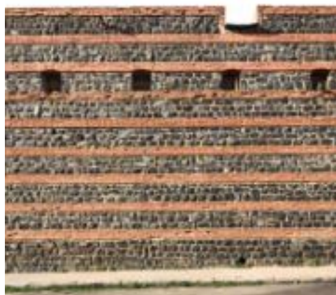
Fig.88 | Muratura listata composta da mattoni in laterizio e blocchi in pietra basaltica usati per la realizzazione di chiusure verticali portanti di edifici commerciali nella fine degli anni '30 ad Asmara.
