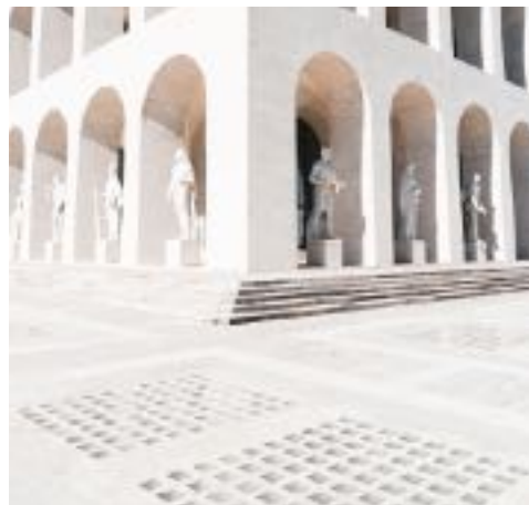
Fig.21 | Vista esterna del basamento del Palazzo della Civiltà Italiana con diffusori in vetrocemento tipo Planilux.
