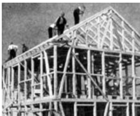
Fig.01 | Immagine storica della costruzione di un edificio con telaio in legno.
