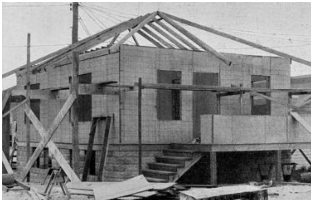
Fig.124 | Costruzioni 'temporanee ed economiche' con le pareti esterne rivestite in Celotex.
