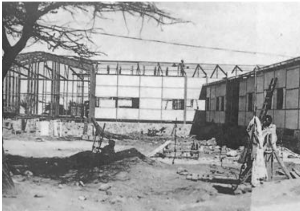
Fig.106 | Insediamenti prefabbricati con brevetto "l'Invulnerabile" e pannelli Eraclit a Dire Dava, Etiopia, in Zagnoni S., "Rassegna, Architettura nelle colonie italiane in Africa", pag.25.
