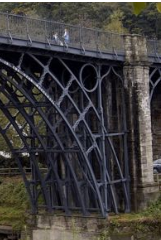
Fig.2 | Particolare costruttivo del Ponte sul fiume Severn. Si noti che non è presente nessuna unione bullonata tra gli elementi strutturali. Per la realizzazione sono state sfruttate le sole tecniche allora conosciute della carpenteria ovvero incastri a coda di rondine tra gli elementi. Si consideri che la trave più grande pesa oltre le 5 tonnellate.
