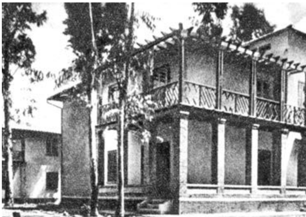
Fig.67 | Foto storica di un villino residenziale realizzato dall'INCIS, denominato "tipo 7 con quattro alloggi", Addis Abeba, 1932.
