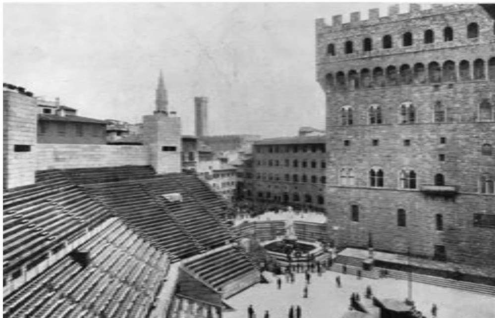
Fig.9 | Interno dell'anfiteatro, in "ERACLIT, PIASTRE LEGGERE PER L'EDILIZIA E RIVESTIMENTI ISOLANTI", Gennaio e Febbraio 1936, Eraclit Vernier S.A. - Portomaghera, Venezia, pag.2.
