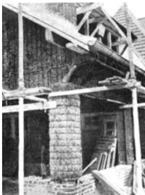
Fig.106 | Murature esterne rivestite con lastre di Solomit curvo prima della posa dello strato di finitura, in "DOMUS", n.49, Gennaio 1932, pag.80.
