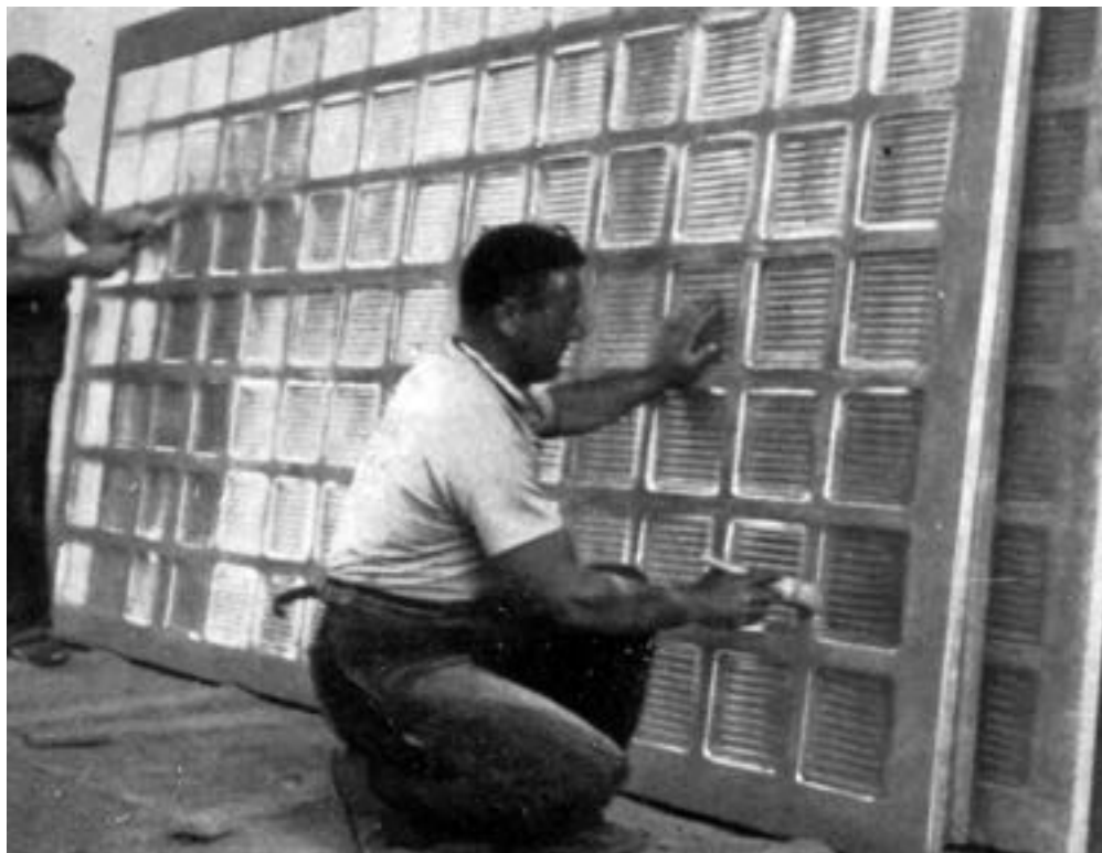
Fig.101 | Pulitura e rifinitura dei giunti del diaframma vetrocementizio (foto De Albertis), in "VETROCEMENTO", Fabbrica Pisana di Specchi e lastre colate di vetro della Società Anonima delle Manifatture di specchi e prodotti chimici di Saint Gobain Chauny & Cirey, "VETROCEMENTO", Milano, 1946, pag.34.
