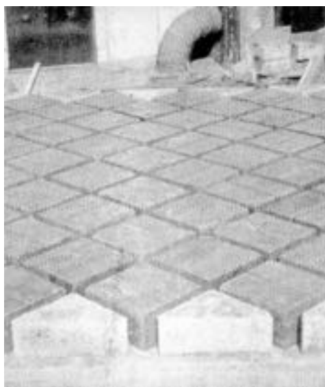
Fig.01 | Immagine della fase di montaggio di un solaio Lares.
