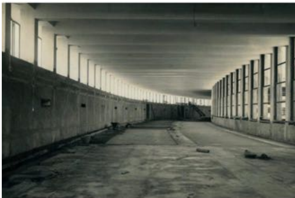
Fig.08 | Foto di cantiere del Palazzo delle Poste di Napoli. In basso posa in opera del Linoleum, in Alfonso Morone, "La fabbrica dell'innovazione - gli arredi del Palazzo delle Poste - Napoli, 1936", Napoli, 2017.
