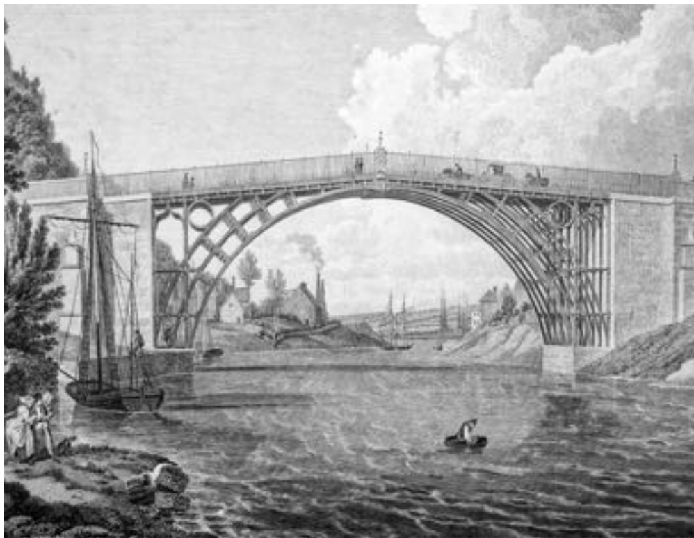
Fig.3 | Litografia storica del ponte "Iron Bridge", sul fiume Severn, Coalbrookdale, 1775-1779. Ponte in ghisa, luce di 30m progettato da John Wilkinson e Abraham Darby.
