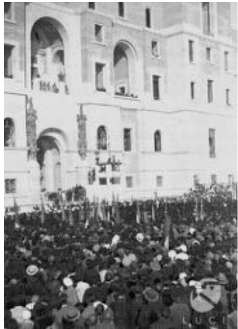
Fig.72 | Inaugurazione, con la presenza di Benito Mussolini, del Palazzo del Governo, progetto dell'architetto Armando Brasini, Taranto, 7 Settembre 1934 (Archivio Istituto Luce).
