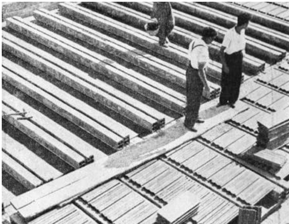
Fig.45 | Montaggio solaio Sapal della RDB Fornaci F.Ili Rizzi Donelli Breviglieri & C, 1944.
