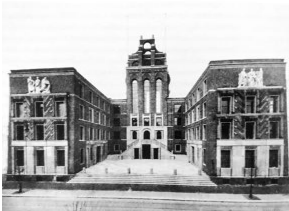
Fig.68 | Progetto primo classificato nel concorso per la “Casa dei Sindacati Fascisti”, progetto degli architetti Angelo Bordini, Luigi Maria Caneva, Antonio Carminati, Milano, 1930.
