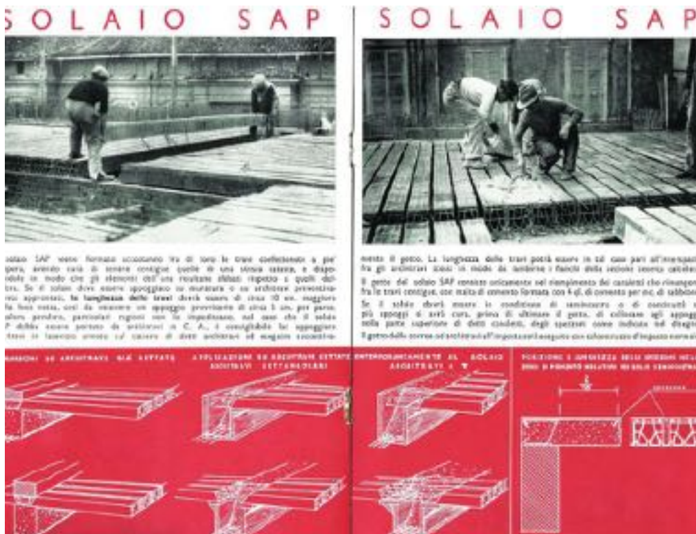
Fig.33 | Scheda tecnica solaio Sap della RDB Fornaci F.Illi Rizzi Donelli Breviglieri & C, 1941.
