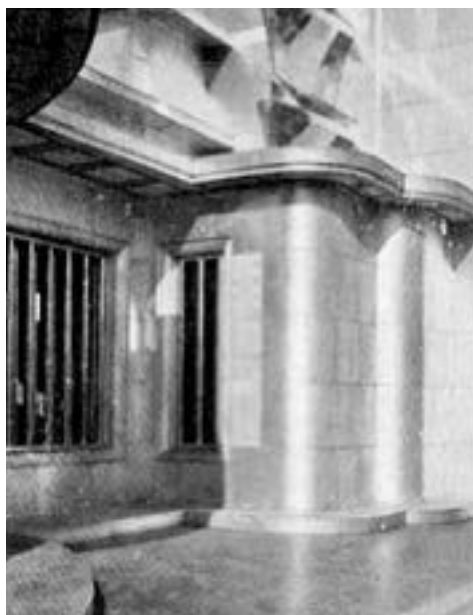
Fig.36 | Rivestimento esterno in Alumàn del Padiglione del porto industriale di Venezia per la Fiera Campionaria di Padova del 1932, dell'architetto Brenno del Giudice, in "ARCHITETTURA" Rivista del sindacato nazionale fascista architetti, n.10, fascicolo 7, 1932, pagg.365,367.
