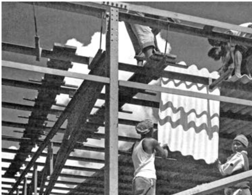
Fig.109 | Montaggio di lastre ondulate in Eternit per una chiusura di copertura su telaio in acciaio (archivio privato).
