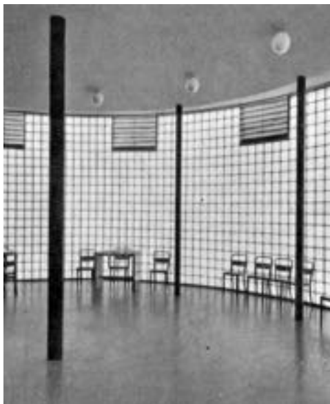
Fig.97 | Padiglione della Riunione Adriatica di Sicurtà - Fiera di Milano, vista interna della chiusura verticale realizzata con diffusori piatti Clarilux, Fabbrica Pisana di Specchi e lastre colate di vetro della Soc. An. delle Manifatture di specchi e prodotti chimici di Saint Gobain Chauny & Cirey, in "IL VETROCEMENTO ARMATO. I SUOI USI, I DIVERSI SISTEMI, I METODI DI POSA", Milano, 1933, pag.23.
