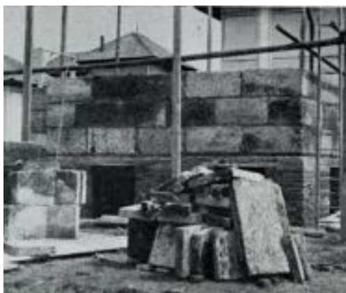
Fig.01 | A sinistra: sistema a blocchi di "Magnesilite". A destra: immagine storica di un cantiere con la posa in opera di blocchi di "Magnesilite" (rif. E. Griffini, "Costruzione Razionale della Casa", IV Edizione, Hoepli, Milano, 1948).
