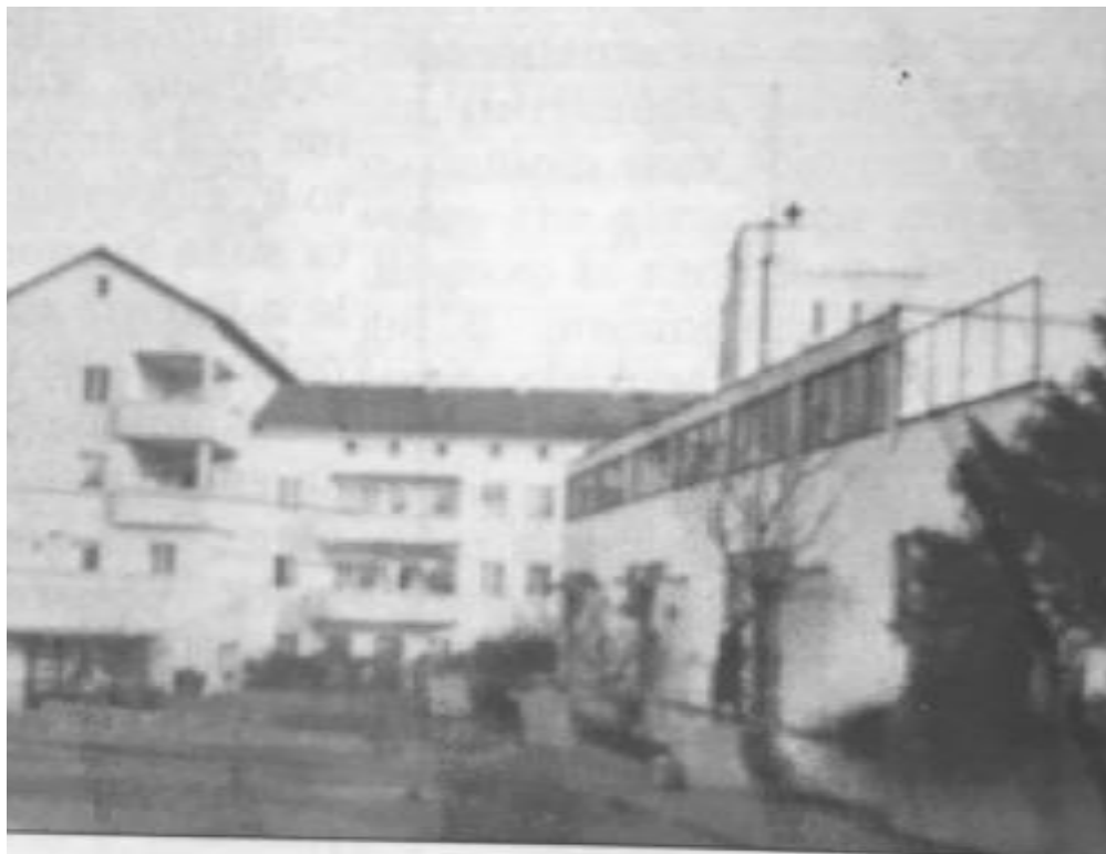
Fig.19 | Foto storica dell'edificio di Behrens, Weissenhof, prima dei restauri, 1983. Si noti il tetto a falde costruito sopra quello a terrazza, foto d'archivio di Marco Dezzi Bardeschi.
