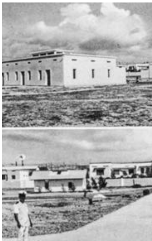
Fig.89 | Nuove costruzioni per la realizzazione dei padiglioni dell'ospedale civile "Principe di Piemonte" per indigeni di Mogadiscio, 1940-41.
