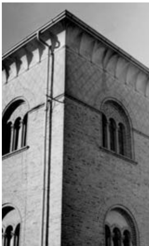
Fig.41 | Dettaglio dello stile architettonico delle prime costruzioni di villini italiani in Eritrea.
