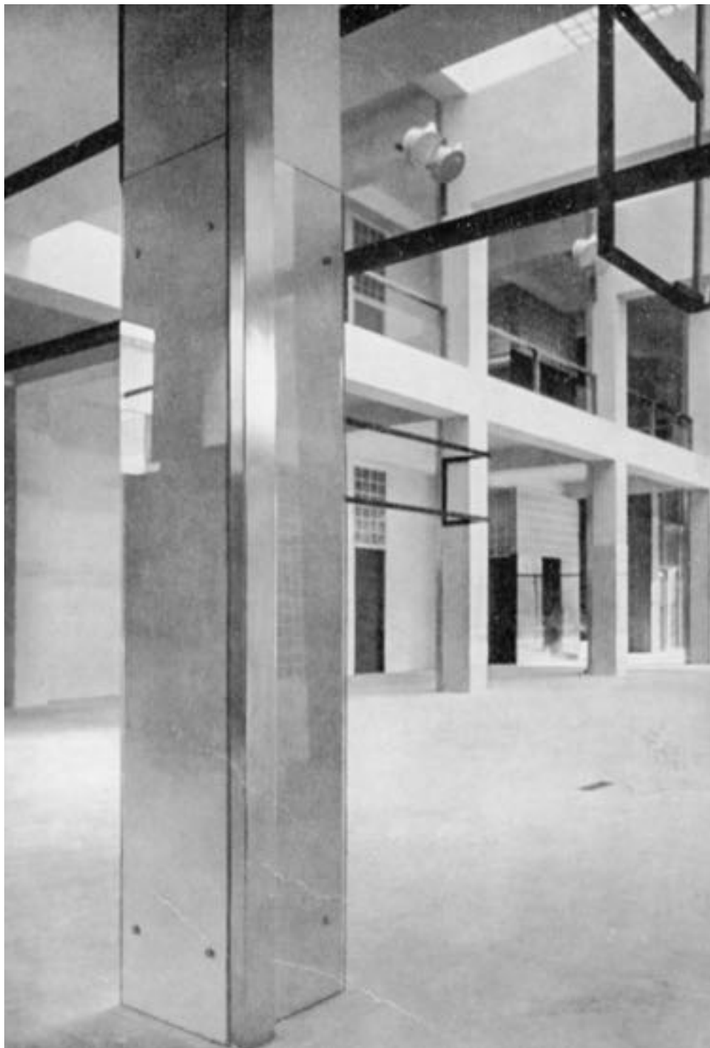
Fig.104 | Applicazione di lega di alluminio della "Società Anonima Lavorazione Leghe Leggere di Milano", Casa del Fascio, progetto dell'architetto Giuseppe Terragni, Como, 1932-1936.
