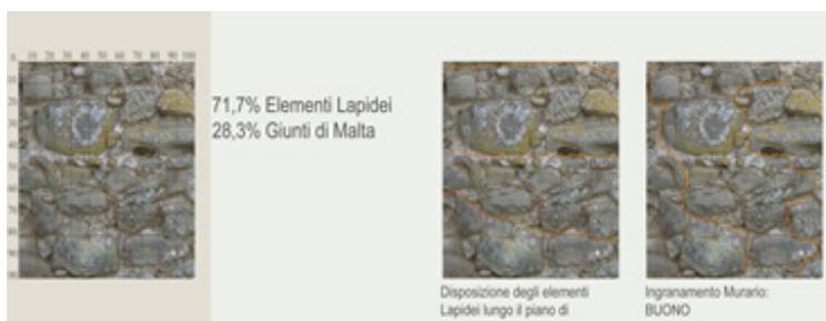
*Foto\_11\_Analisi metrica dell'apparecchiatura muraria*
