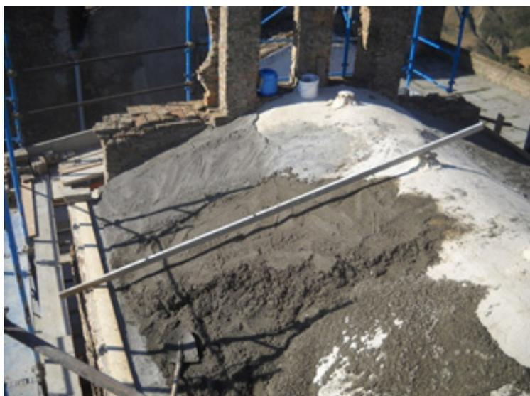
*Ricostituzione del rinfiacco delle volte in cls alleggerito e rifacimento del pacchetto di copertura*
