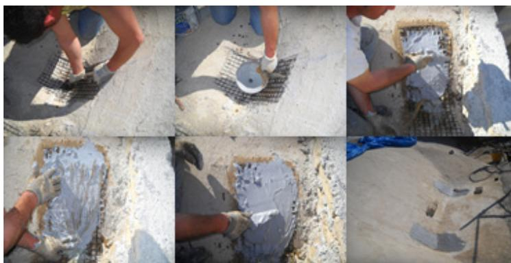
*Posa in opera di connettori in fibra di carbonio ad alta resistenza fissato con stucco epossidico per effettuare le connessioni strutturali - fasi lavorative.*
