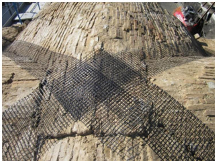
*Consolidamento delle volte con fibre di carbonio*
