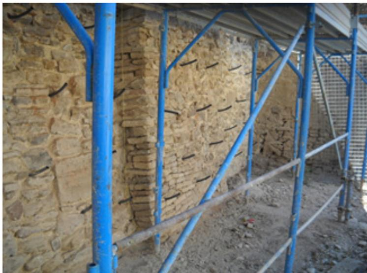
*Consolidamento delle murature mediante iniezioni di malta a bassa pressione*
