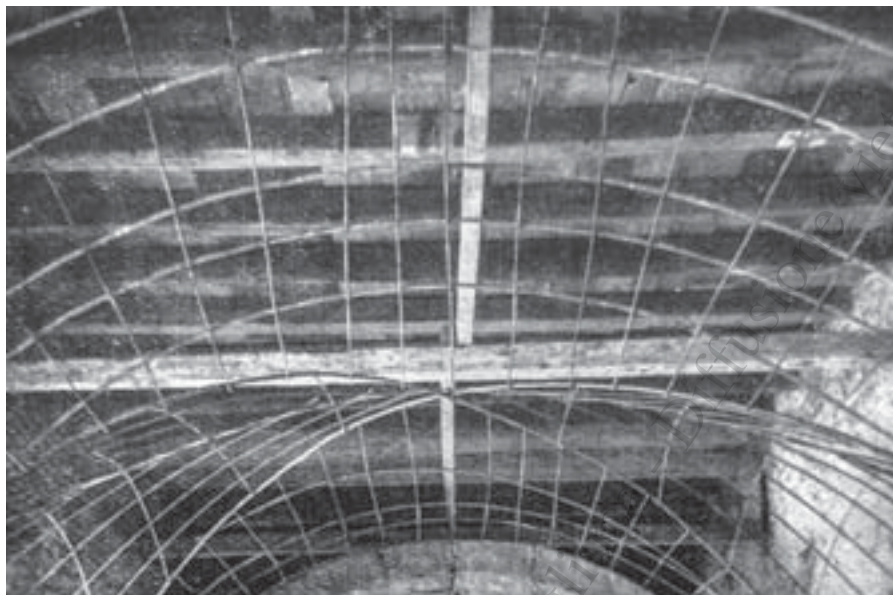
Volta asismica in Graticcio Stauss della Palestra Comunale di Senigallia, in Società Italiana Stauss, "Graticcio Stauss. Il materiale da costruzione moderno", Istituto grafico Bertello, Cuneo, 1935, pag.56.
