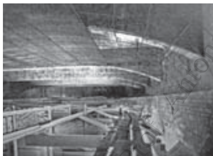
Volta asismica in Graticcio Stauss della Palestra Comunale di Senigallia, in Società Italiana Stauss, "Graticcio Stauss. Il materiale da costruzione moderno", Istituto grafico Bertello, Cuneo, 1935, pag.56.
