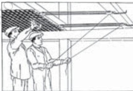
Fase 5a: tensione delle stuoie in Graticcio Stauss con "taglie tendifili" per la realizzazione di plafonature.
