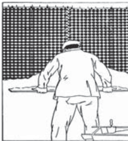
Fase 7: lisciatura del Graticcio Stauss.
