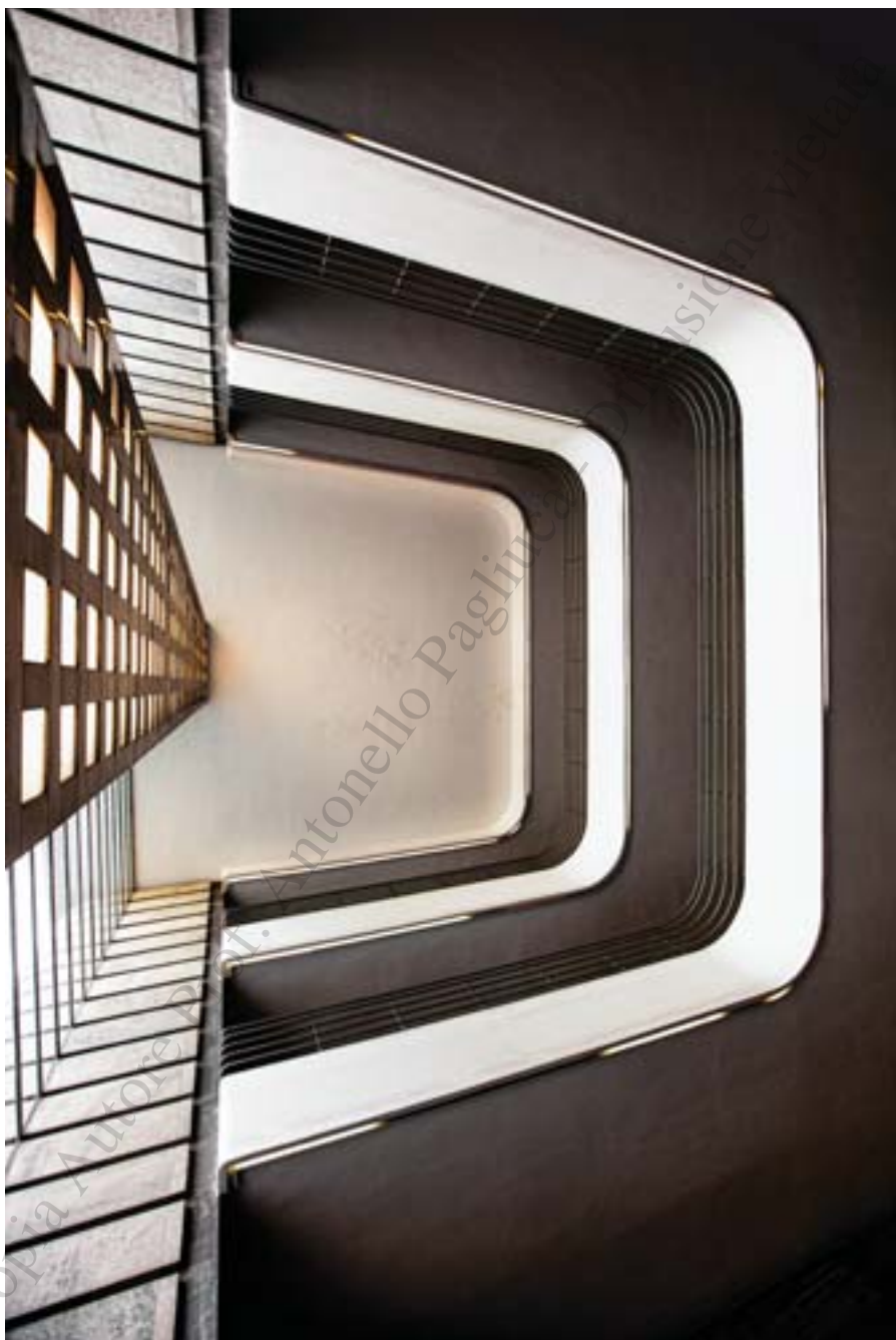
Realizzazione della passerella con struttura metallica e successivo rivestimento in stuoie di Graticcio Stauss e intonaco del Palazzo delle Poste e Telegrafi a Napoli, progettato dall'architetto Giuseppe Vaccaro e Gino Franzì nel 1936.
