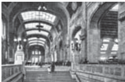
Plafone sagomato del Palazzo delle Poste di Napoli (in alto) e volte della galleria della Stazione Centrale di Milano realizzati in Graticcio Stauss, in Società Italiana Stauss, "Graticcio Stauss. Il materiale da costruzione moderno", Istituto grafico Bertello, Cuneo, 1935.
