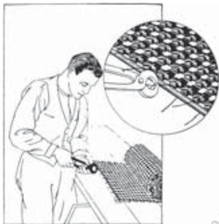
Fase 4: armatura delle stuoie in Graticcio Stauss.
