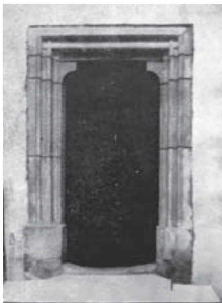
Risultato finale dell'isolamento di murature salnitrose e umide con il Graticcio Stauss e successiva intonacatura, in Società Italiana Stauss, "Graticcio Stauss. Il materiale da costruzione moderno", Istituto grafico Bertello, Cuneo, 1935, pag.41.
