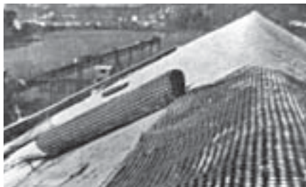
Graticcio Stauss applicato in copertura, in Società Italiana Stauss, "Graticcio Stauss. Il materiale da costruzione moderno", Istituto grafico Bertello, Cuneo, 1935, pag.41.
