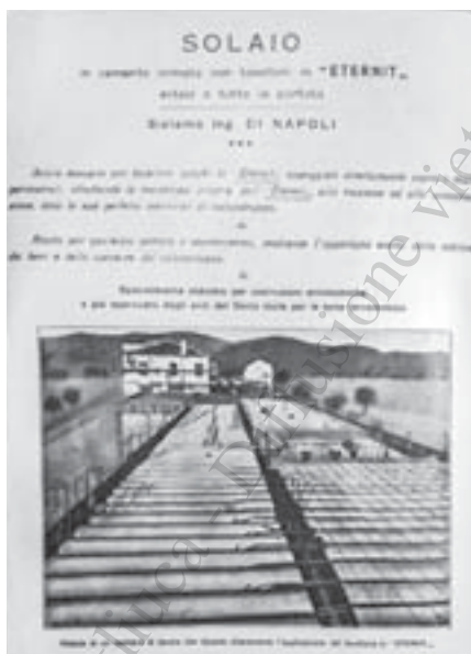
Tavelloni in Eternit (assonometria e vista di un cantiere con applicazione del sistema costruttivo) in Catalogo generale "ETERNIT PIETRA ARTIFICIALE - SOCIETÀ ANONIMA" Genova, 1928.
