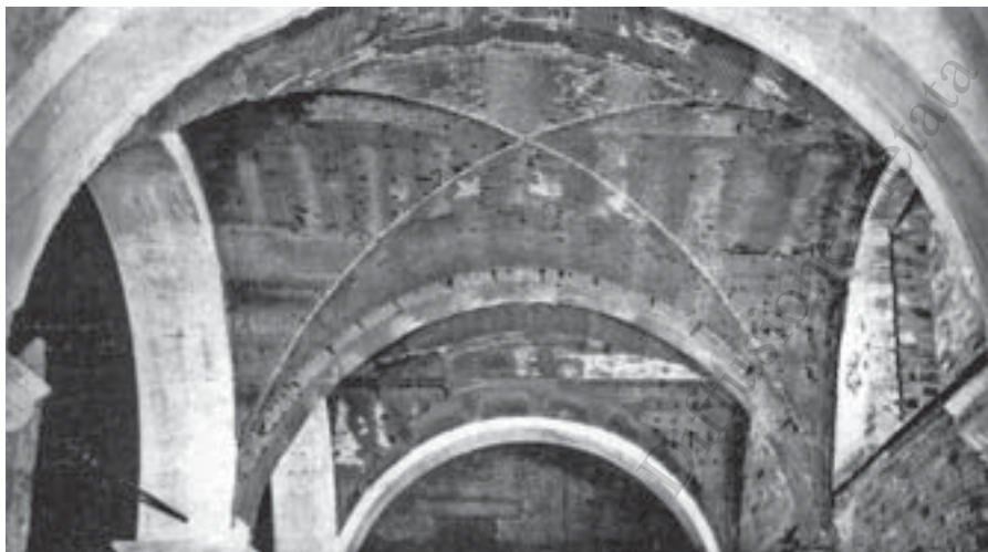
Volta a crociera del Palazzo Comunale di Senigallia eseguita con il Graticcio Stauss, in "DOMUS", n.88, Aprile 1935, pag.50.
