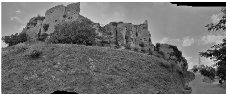
Figura 8. Assoro. Il castello. Vista panoramica (foto dell'Autore).
