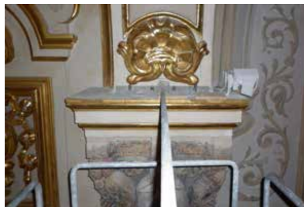
Fig. 6.36 Particolare dell'ancoraggio a radice di una catena nell'aula liturgica
