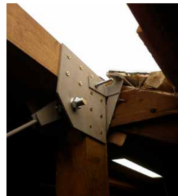
Fig. 6.34 Particolare ancoraggio piastre in acciaio del telaio in legno
