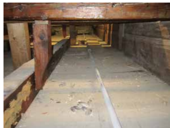
Fig. 6.32 Catena metallica (diametro \varnothing 30 ) posizionata longitudinalmente nel sottotetto della navata centrale
