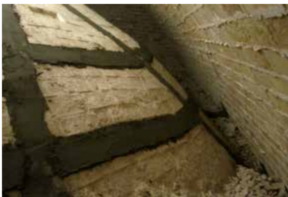
Fig. 6.35 Fasciature con materiale fibrorinforzato della cupola realizzate nello spazio interstiziale tra la cupola e la copertura della stessa
