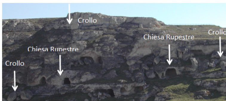
Figura 17. Belvedere delle Chiese Rupestri. Blocchi calcarenitici in precario stato di stabilità o già crollati in prossimità di testimonianze rupestri
