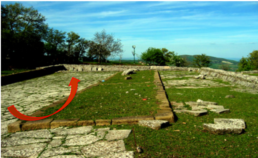
Figura 9. Basolato carbonatico contenente l'altare del Santuario in chiara contropendenza da scorrimento rototraslazionale
