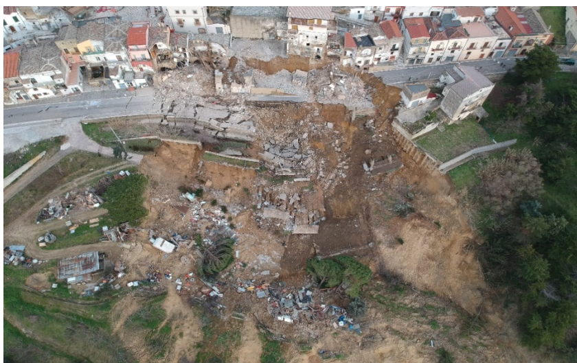
Figura 2. La grande frana di Pomarico del gennaio 2019. Particolare dell'area di distacco e delle macerie prodotte dal movimento franoso.
