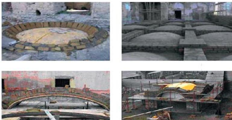
**Figura 1. Interventi di consolidamento e ricostruzione delle volte [Voto S., Acanfora M. Manfredi. G.2007] [rif]**
