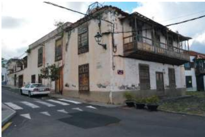
(4) Ejemplo del deterioro progresivo
