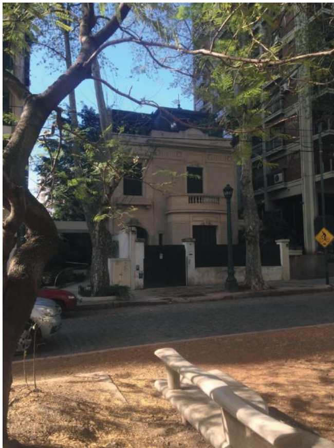
Foto 4.Fachada Av.de los Incas 3360
