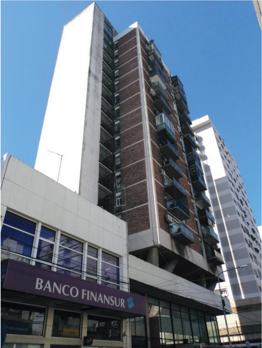
(Fig. 1) Edificio ex banco Avellaneda, Arq. Mario Roberto Álvarez. Quilmes.
