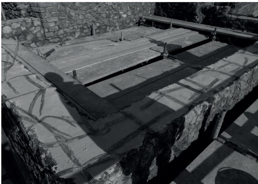
Fig.2 Posa in opera delle fibre di Basalto
