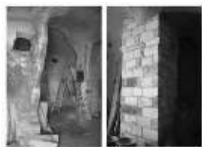
Fig.3: Realizzazione di un appoggio puntuale di consolidamento (prima e dopo)
