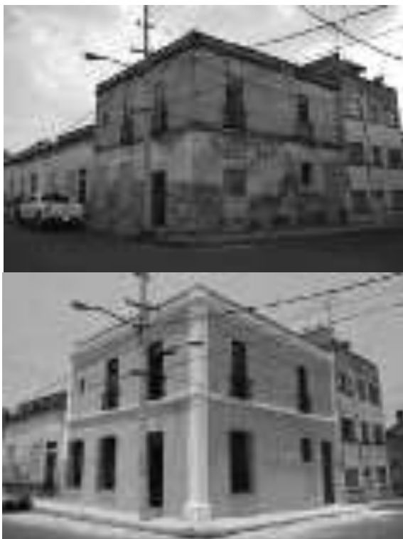
Fig. 13 Fachadas antes de la intervención Fachadas después de la intervención
