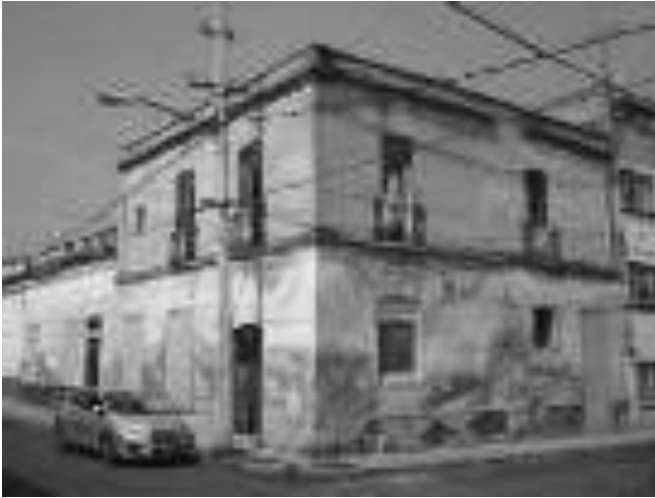
Fig. 9 Fachadas del inmueble
