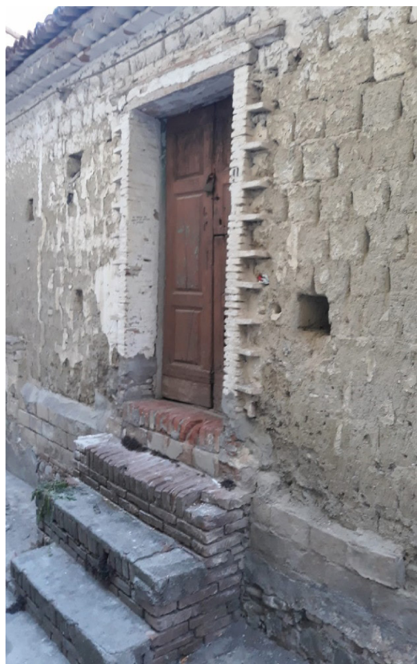
Fig. 3. Senise (PZ). Struttura da lavoro, vista principale.
