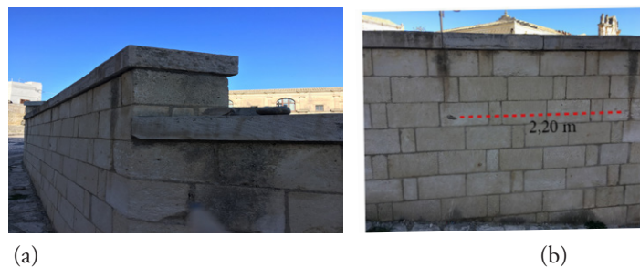
Figura 6. (a) Parapetto in blocchi squadri nel Sasso Barisano. (b) Indicazione del profilo di misura.
