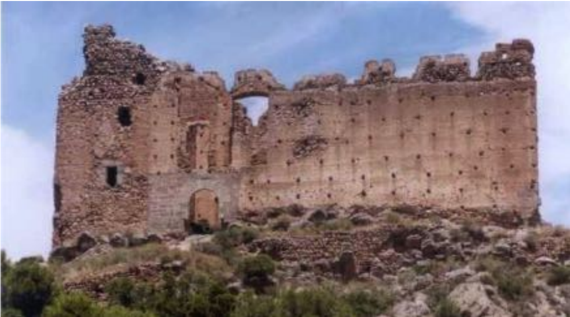
Figura 10 Facciata principale del Castello di Beselga. Castel of Beselga main facade
