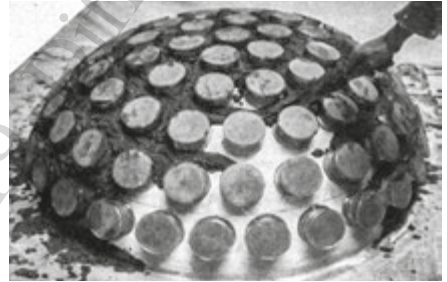
4. Primo strato di cemento e disposizione dei ferri.
