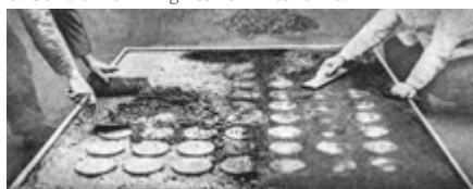
7. Getto dello strato impermeabile e pulitura abrasiva.
