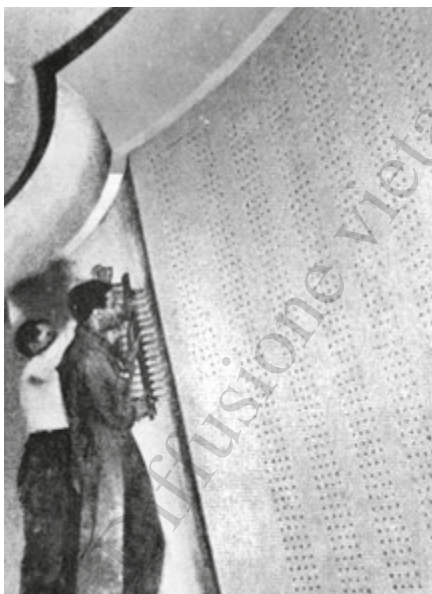
Cinema Roma di Vicenza (L. Quagliata), esempio di posa in opera di Vetroflex (a sinistra) e foratura dello strato di intonaco e retrostante Vetroflex con trapani multipli, in "ARCHITETTURA" Rivista del sindacato nazionale fascista architetti, Giugno 1936, pag.287.
