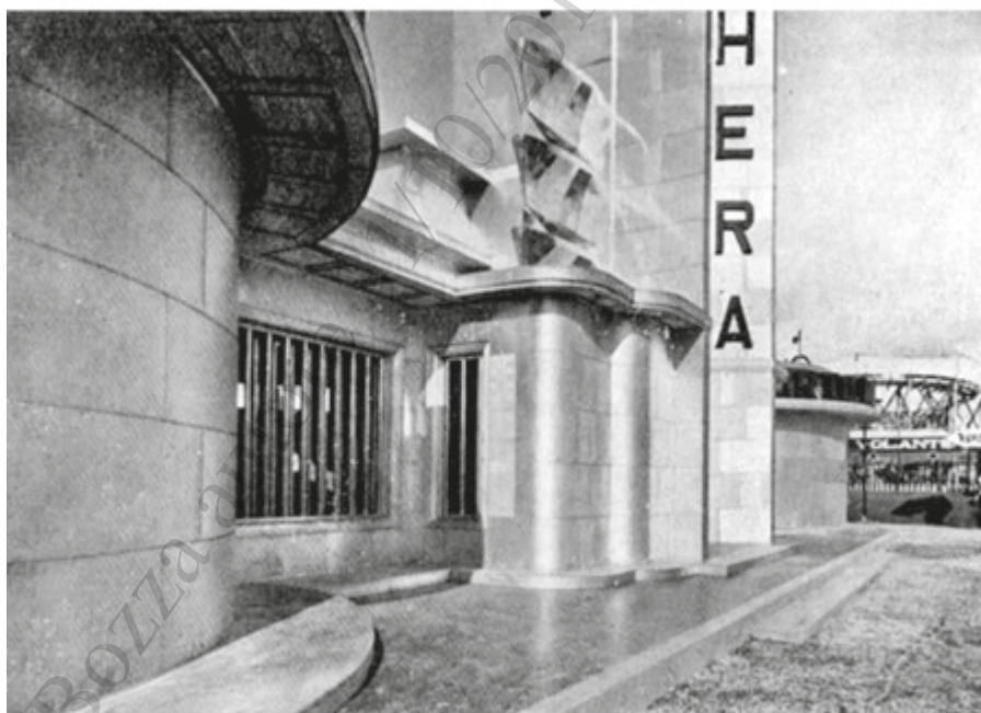
Rivestimento esterno in Alumàn del Padiglione del porto industriale di Venezia per la Fiera Campionaria di Padova del 1932, dell'architetto Brenno del Giudice, in "ARCHITETTURA" Rivista del sindacato nazionale fascista architetti, n.10, fascicolo 7, 1932, pagg.365,367.
