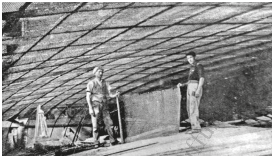
Plafone a volta del Cinema Impero di Biella realizzato in Graticcio Stauss, in Società Italiana Stauss, "Graticcio Stauss. Il materiale da costruzione moderno", Istituto grafico Bertello, Cuneo, 1935, pag.75.
