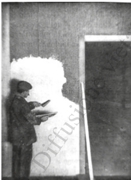
Fasi di intonacatura del Graticcio Stauss, in Società Italiana Stauss, "Graticcio Stauss. Il materiale da costruzione moderno", Istituto grafico Bertello, Cuneo, 1935, pagg.32-33.
