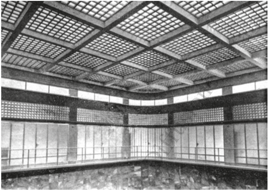
Cassa di Risparmio di Ravenna. Copertura con piastrelle Planilux Q.2020 e pareti con piastrelle Nevada H.154, eseguita dalla "A. Pritoni & C. di Bologna, Fabbrica Pisana di Specchi e lastre colate di vetro della Soc. An. delle Manifatture di specchi e prodotti chimici di Saint Gobain Chauny & Cirey, in "VETROCEMENTO", Milano, 1946, pag.7.
