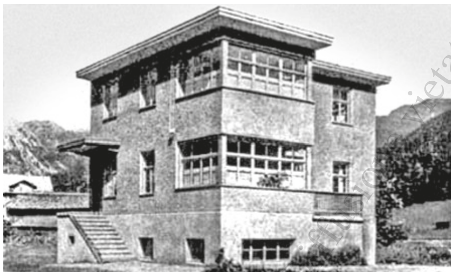
Villetta per due alloggi realizzata con struttura intelaiaata in legno e rivestita esternamente con lastre di Eraclit dello spessore di 5cm (esternamente) e 2.5cm (internamente), in "ARCHITETTURA - RIVISTA DEL SINDACATO NAZIONALE FASCISTA ARCHITETTI", Marzo 1932, fascicolo III, pag.148.
