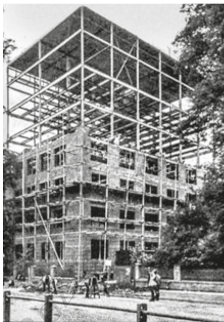
Struttura intelaiata in acciaio con riempimento in conglomerati ed isolamento termoacustico interno ed esterno in pannelli di Eraclit, in "DOMUS", n.60, Dicembre 1932, pag.106.
