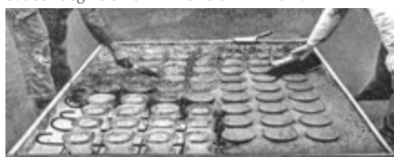
6. Getto di boiaccia grassa e calcestruzzo.
