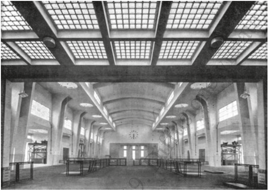
Mercato del pesce di Milano. Lucernari realizzati con diffusore Iperfan VS 39 (ingresso) e con VS 19 (piani laterali), Società Anonima Vetraria "Fidenza", in "IPERFAN VETROCEMENTO", Arti grafiche "La Milano", Milano, pag.8.
