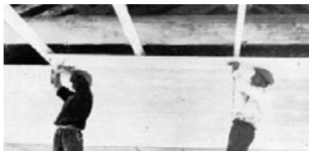
Applicazione di lastre in Velox ed esempi di volte e cassettonati, in "ITALCEMENTI", Editrice A. e Elli Cattaneo, Bergamo, 1943.
