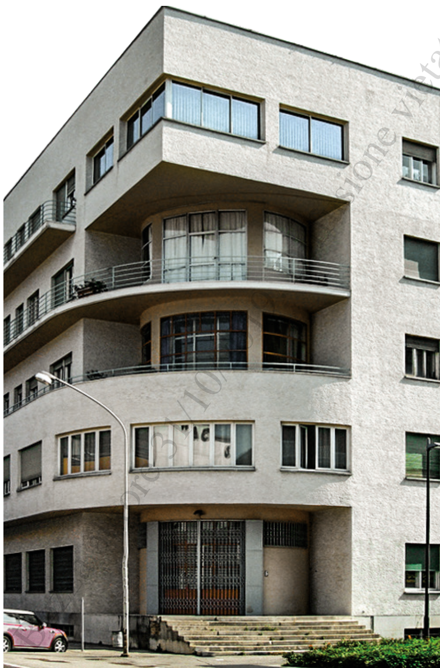
Novocomun, prospetto con bicromia dell'intonaco Terranova dell'architetto Giuseppe Terragni, Como, 1929.
