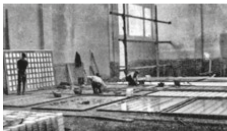
5-6. Stagionatura aerea, dopo un periodo di maturazione subacquea (foto De Albertis), in "VETROCEMENTO", Fabbrica Pisana di Specchi e lastre colate di vetro della Società Anonima delle Manifatture di specchi e prodotti chimici di Saint Gobain Chauny & Cirey, "VETROCEMENTO", Milano, 1946, pagg.32-33.
