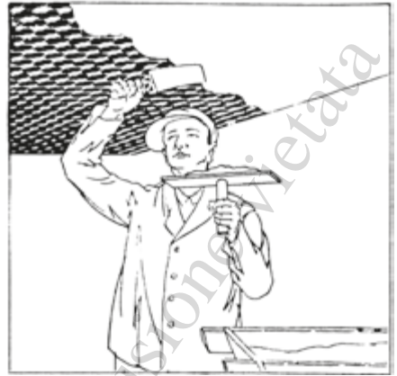
Fase 6: intonacatura del Graticcio Stauss.
