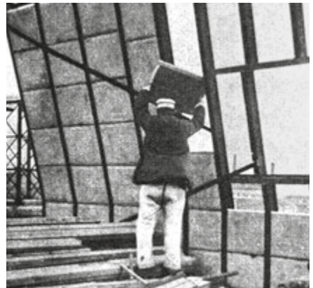
Montaggio di pannelli in Cellulite.
