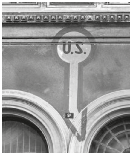
Segnaletica distintiva per la protezione antiaerea sulla facciata di un edificio di Trieste.
