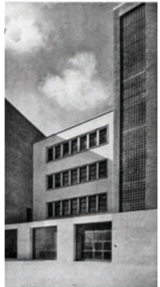
Governatorato di Roma - Scuole elementari di Ostia, in "IL VETROCEMENTO DELLA S.A.I.V.A. - BREVETTI LUXFER", a cura dell'Editoriale Domus S.A., Milano, 1937, pag.22.
