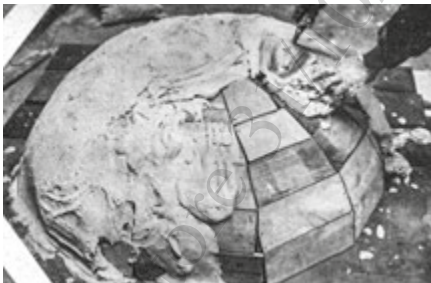
2. Applicazione dello strato di gesso e levigatura.
