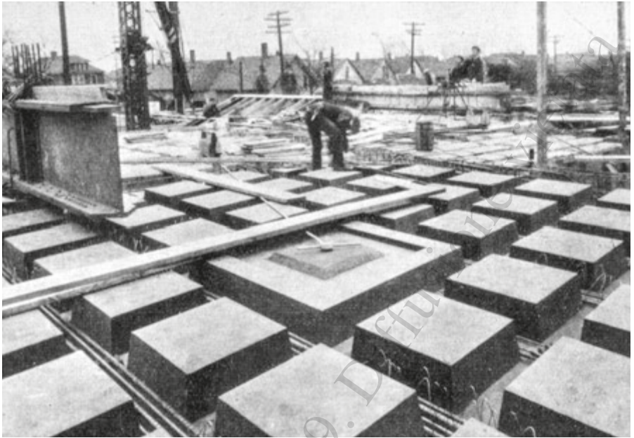
Applicazione di Masonite quale materiale di alleggerimento per la realizzazione di orizzontamenti a nervature parallele in calcestruzzo armato, in Griffini E., "Costruzione Razionale della Casa", Hoepli, Milano, 1932, pag.79.
