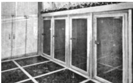
Nuova sede della Stipel di Milano, progettato dall'architetto Carlo E. Rava. Cabine di serie in cristallo rigato ed opalina nera di rivestimento, in "DOMUS", n.174, Giugno 1942, pag.52.
