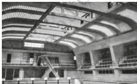
Piscina del Campo Sportivo di Aquila (costruzione antisismica), progetto dell'architetto P Vietti, in "IL VETROCEMENTO ARMATO. I SUOI USI, I DIVERSI SISTEMI, I METODI DI POSA", Milano, 1933, pag.9.
