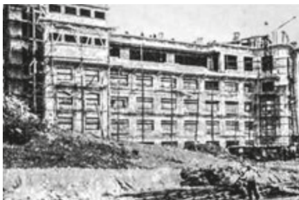
Albergo in Solomit su scheletro in calcestruzzo armato, in "DOMUS", n.49, Gennaio 1932, pag.79.
