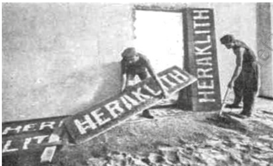
Immagine storica della posa in opera di lastre in Eraclit per la coibenza termoacustica a pavimento; lastre dello spessore di 2.5cm posate su un letto di sabbia, in "DOMUS", n.60, Dicembre 1932, pag.106.
