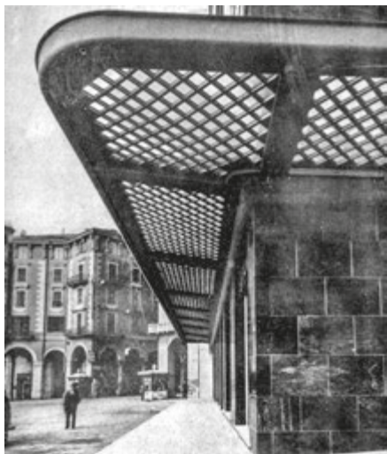
Pensilina con diffusori Duralux Q. 187 del grattacielo Pancaldo di Savona, progettato dall'architetto M. Angelini, in "VETROCEMENTO", Milano, 1946, pag.41.
