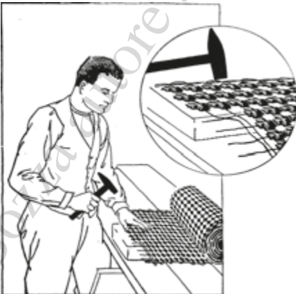
Fase 2: unione delle stuoie in Graticcio Stauss.
