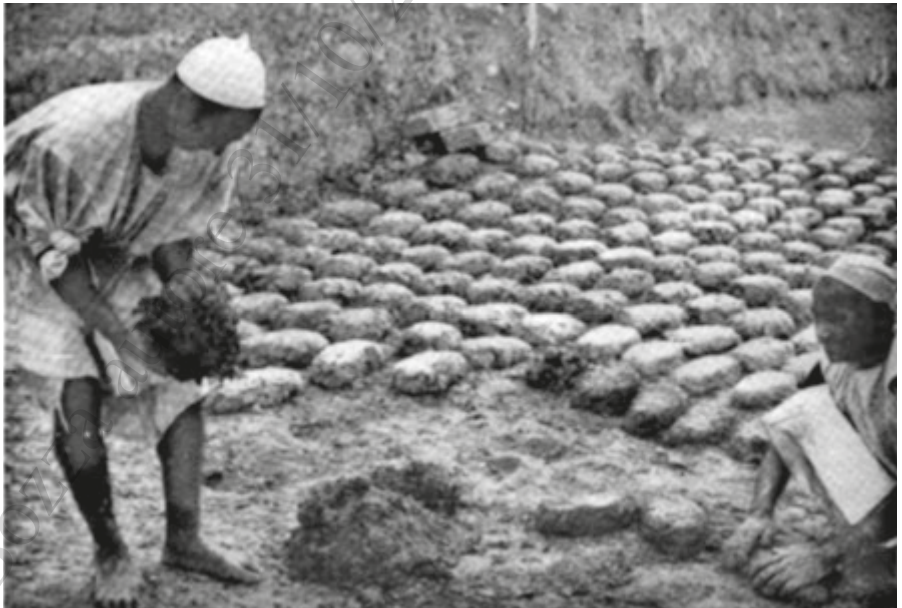
Immagine storica realizzazione mattoni in argilla in Etiopia, in "La rivista illustrata del Popolo d'Italia" vol. 2, 1935, Milano (1923-1943 - Alfieri e Lacroix).
