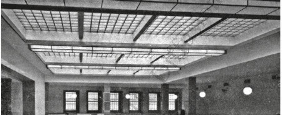
Copertura isolante termo-acustica della Cassa di Risparmio di Trento, in "IL VETROCEMENTO DELLA S.A.I.V.A. - BREVETTI LUXFER", a cura dell'Editoriale Domus S.A., Milano, 1937, pag.14.
