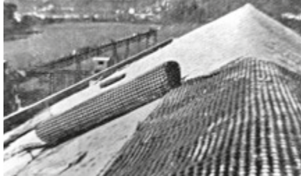
Graticcio Stauss applicato in copertura, in Società Italiana Stauss, "Graticcio Stauss. Il materiale da costruzione moderno", Istituto grafico Bertello, Cuneo, 1935, pag.41.
