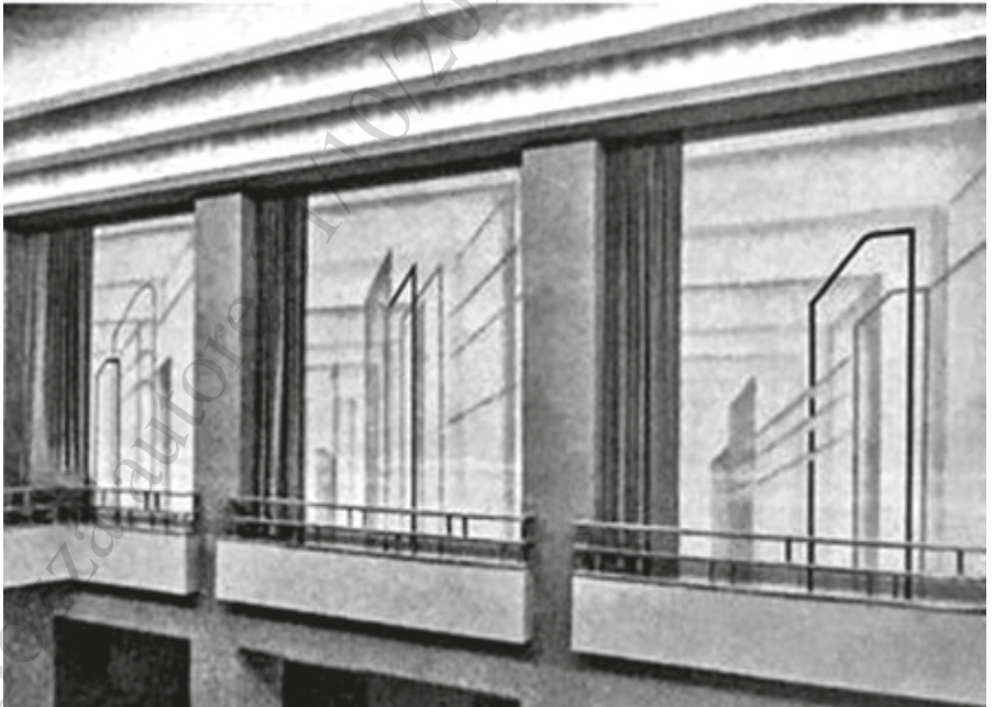
Applicazione di elementi in Cromalluminio per corrimano ed altri elementi di finitura interni all'interno del Cinematografo dell'architetto Pier Nicolò Berardi, in "ARCHITETTURA" Rivista del Sindacato Nazionale Fascista Architetti, n.11, fascicolo 12, Milano, 1932.
