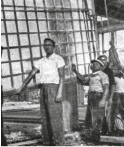
Intradosso di una cupola realizzata con diffusori del tipo "Cupolux", in "IL VETROCEMENTO ARMATO. I SUOI USI, I DIVERSI SISTEMI, I METODI DI POSA", Milano, 1933, pag.16.
