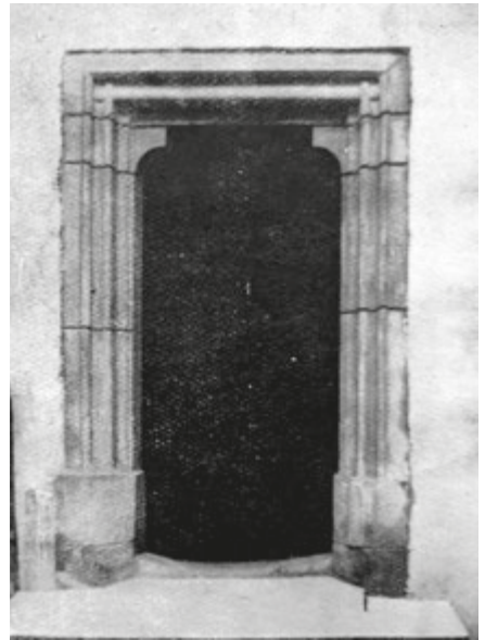
Risultato finale dell'isolamento di murature salnitrose e umide con il Graticcio Stauss e successiva intonacatura, in Società Italiana Stauss, "Graticcio Stauss. Il materiale da costruzione moderno", Istituto grafico Bertello, Cuneo, 1935, pag.41.
