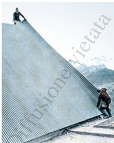
Applicazione di una copertura in lastra ondulata Vipla, in "DOMUS", n.397, Dicembre 1962, pag.147.
