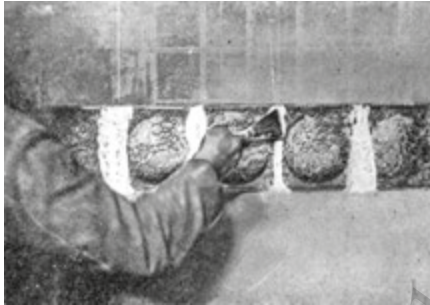
2. Stuccatura con gesso dei giunti distanziati 2-4mm.
