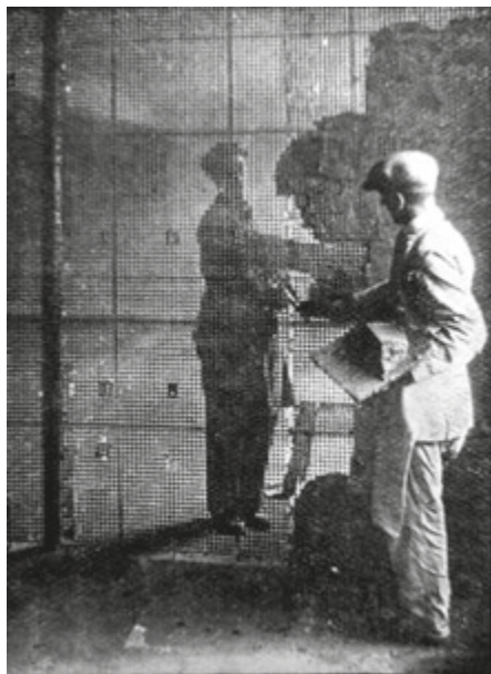
Fasi di intonacatura del Graticcio Stauss, in Società Italiana Stauss, "Graticcio Stauss. Il materiale da costruzione moderno", Istituto grafico Bertello, Cuneo, 1935, pagg.32-33.
