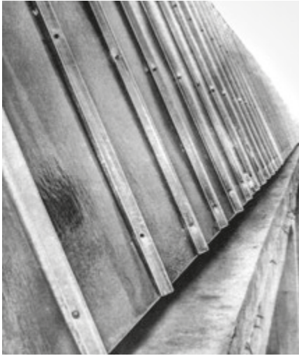
Particolare di una lastra di copertura in Gabraster, in "DOMUS", n.397, Dicembre 1962, pag.146.
