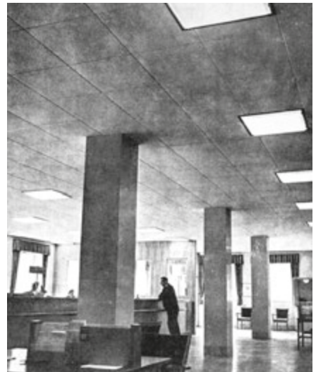
Immagine storica applicazione interna di pannelli in Soundex, in "DOMUS", n.283, Giugno 1953, pag.12.
