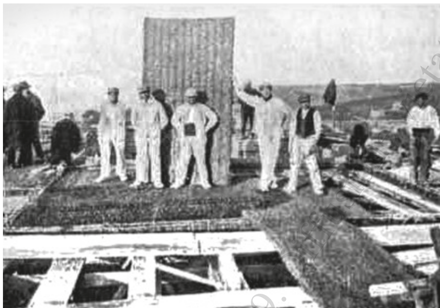
Immagine storica della posa di una sottoarmatura in Solomit, in "DOMUS", n.49, Gennaio 1932, pag.79.
