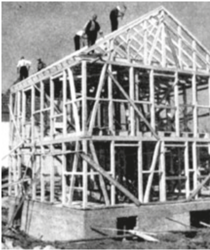
Immagine storica di una struttura a telaio ligneo e tamponamento in pannelli di Magnesilite (archivio privato).
