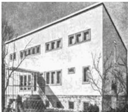
Casa di campagna presso Berlino, dell'architetto Egon Eiermann e Joenecke. Esempio di applicazione del sistema costruttivo con telaio in legno ed Eraclit da 5cm, in "DOMUS", n.60, Dicembre 1932, pag.104.
