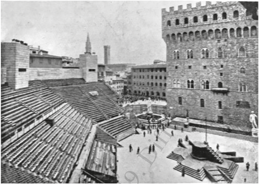
Interno dell'anfiteatro, in "ERACLIT, PIASTRE LEGGERE PER L'EDILIZIA E RIVESTIMENTI ISOLANTI", Gennaio-Febbraio 1936, Eraclit Vernier S.A. - Portomaghera, Venezia, pag.2.
