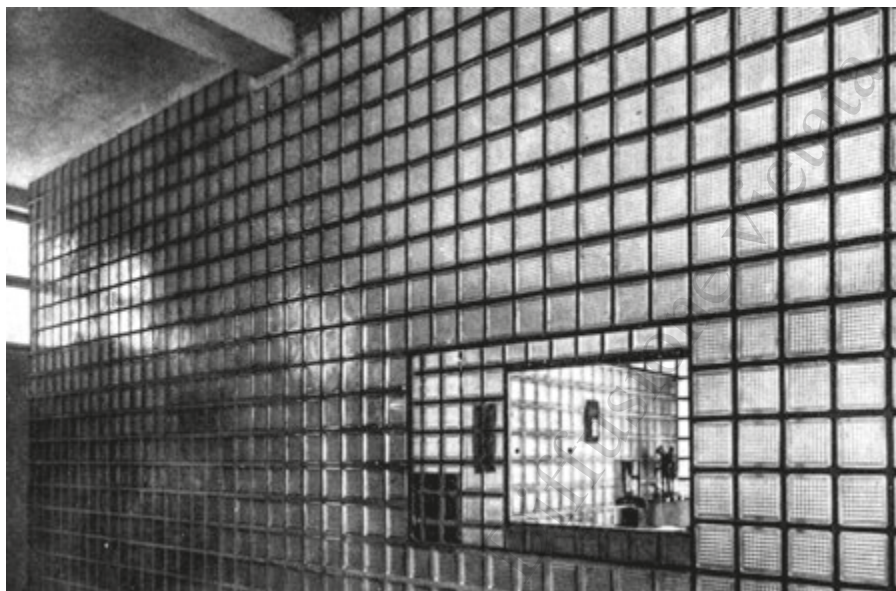
Partizione interna in Isocalor Q.2040, Uffici della sede della ditta “B. Chierichetti” di Milano, progetto dell’ingegnere Ugo Chiumenti, Fabbrica Pisana di Specchi e lastre colate di vetro della Società Anonima delle Manifatture di specchi e prodotti chimici di Saint Gobain Chauny & Cirey, in “IL VETROCEMENTO”, Milano, 1946, pag.47.
