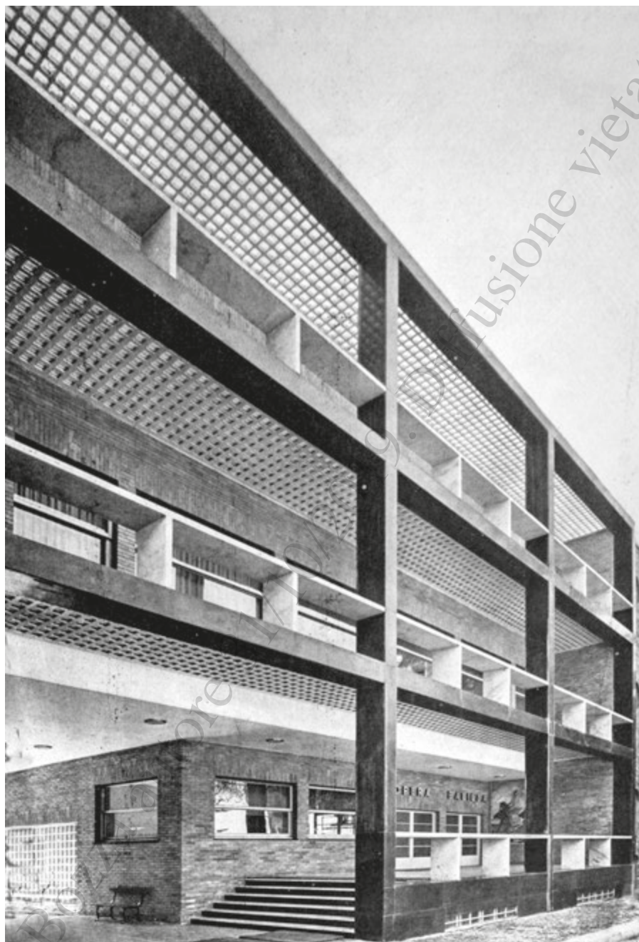
Opera Nazionale Balilla di Milano con ballatoi realizzati con Iperfan VS 40. Progetto realizzato nel 1934 dall'architetto Mario Cereghini, Società Anonima Vetraria "Fidenza", in "IPERFAN VETROCEMENTO", Arti grafiche "La Milano", Milano, pag.12.
