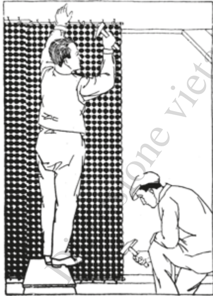
Fase 5: fissaggio nelle costruzioni in legno delle stuoie in Graticcio Stauss mediante “grappe” metalliche.
