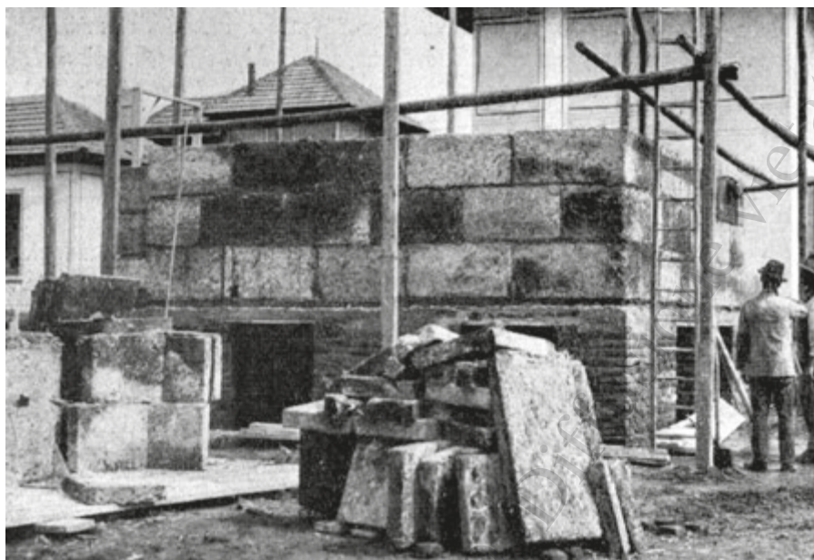
Immagine storica di una costruzione realizzata in blocchi di Magnesilite, in Griffini E., “Costruzione Razionale della Casa”, Hoepli, Milano, 1932, pag.90.
