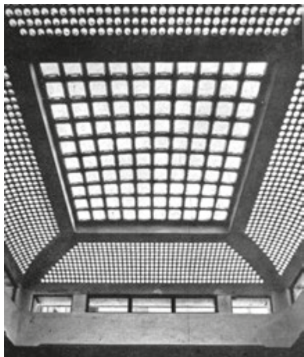
Cupola in vetrocemento di un edificio privato a Roma, realizzata dalla Soc. An. Italiana Vetrocemento armato, in "IL VETROCEMENTO ARMATO. I SUOI USI, I DIVERSI SISTEMI, I METODI DI POSA", Milano, 1933, pag.8.
