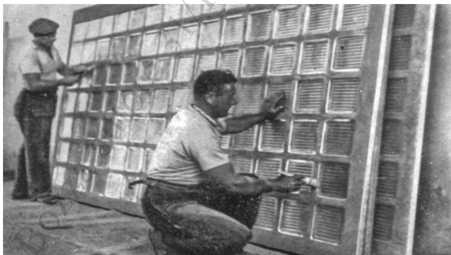
8. Pulitura e rifinitura dei giunti del diaframma vetrocementizio (foto De Albertis), in "VETROCEMENTO", Fabbrica Pisana di Specchi e lastre colate di vetro della Società Anonima delle Manifatture di specchi e prodotti chimici di Saint Gobain Chauny & Cirey, "VETROCEMENTO", Milano, 1946, pag.34.
