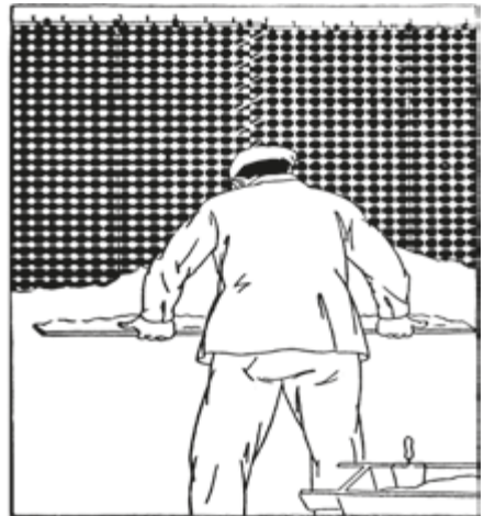
Fase 7: lisciatura del Graticcio Stauss.
