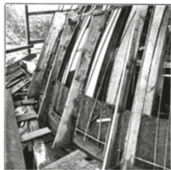
Centine esterne di guida per la caseratura esterna. Centine interne a T sulle quali venno appoggiate le piastre che rimarranno saldamente attaccate al getto della soletta formando un perfetto rivestimento isolante. Prog. Ing. L. Stefanon
