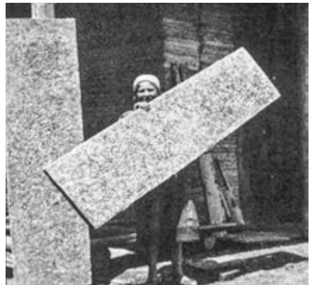
Lastre di Eraclit dello spessore di 7cm appena prodotta, in "DOMUS", n.55, Luglio 1932, pag.68.
