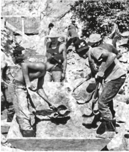
Immagine storica di un cantiere; preparazione di malta cementizia con additivo Riunito (archivio privato).
