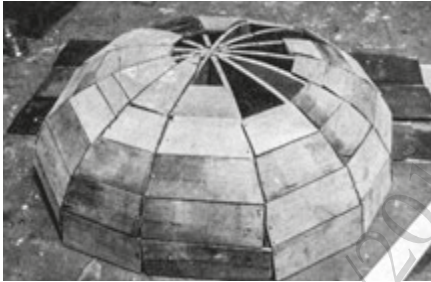
1. Esecuzione della centina in legno.
