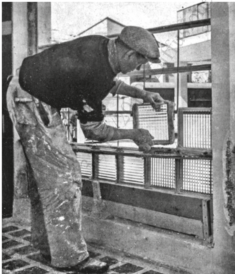
Costruzione di una muratura con diffusori Isocalor (archivio Italfoto), Fabbrica Pisana di Specchi e lastre colate di vetro della Società Anonima delle Manifatture di specchi e prodotti chimici di Saint Gobain Chauny & Cirey, in "VETROCEMENTO", Milano, 1946, pag.37.
