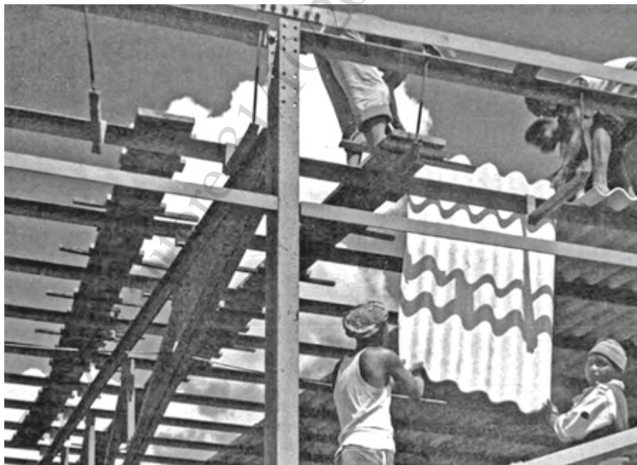
Montaggio di lastre ondulate in Eternit per una chiusura di copertura su telaio in acciaio (archivio privato).
