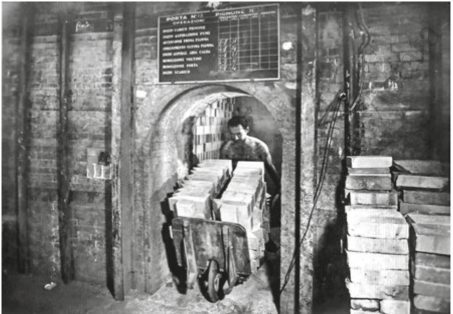
Carico dei mattoni refrattari in appositi magazzini di essiccamento. Immagine storica della Fabbrica Refrattari Verzocchi di La Spezia, (archivio sezione Unità Cura e Gestione delle Collezioni del Comune di Forlì).
