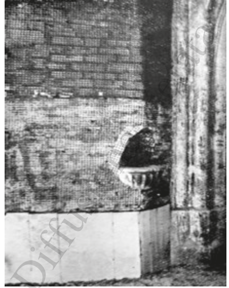
Isolamento di murature salnitrose e umide con il Graticcio Stauss, in Società Italiana Stauss, "Graticcio Stauss. Il materiale da costruzione moderno", Istituto grafico Bertello, Cuneo, 1935, pag.41.
