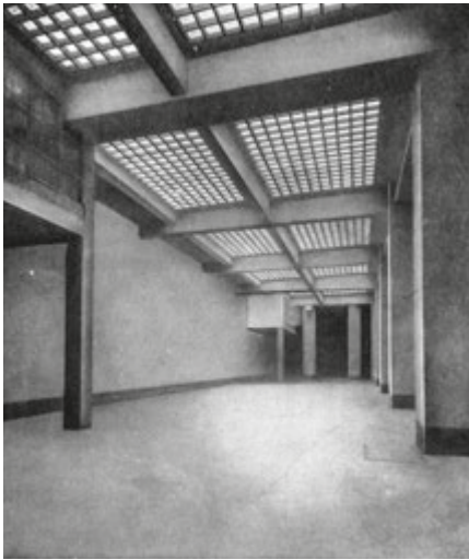
Casa privata a Milano. Sotterraneo con lucernari realizzati con diffusori Iperfan VS 31, Società Anonima Vetraria "Fidenza", in "IPERFAN VETROCEMENTO", Arti grafiche "La Milano", Milano, pag.18.
