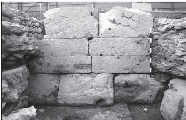
5. Rivestimento in blocchi di travertino conservato lungo la parete occidentale della nicchia tra i due templi. (S.E. Zanelli)
