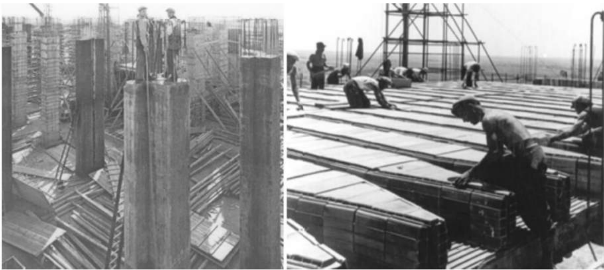
Figura4. Foto storica della realizzazione del solaio Bidelta. ( www.doccity.com )
