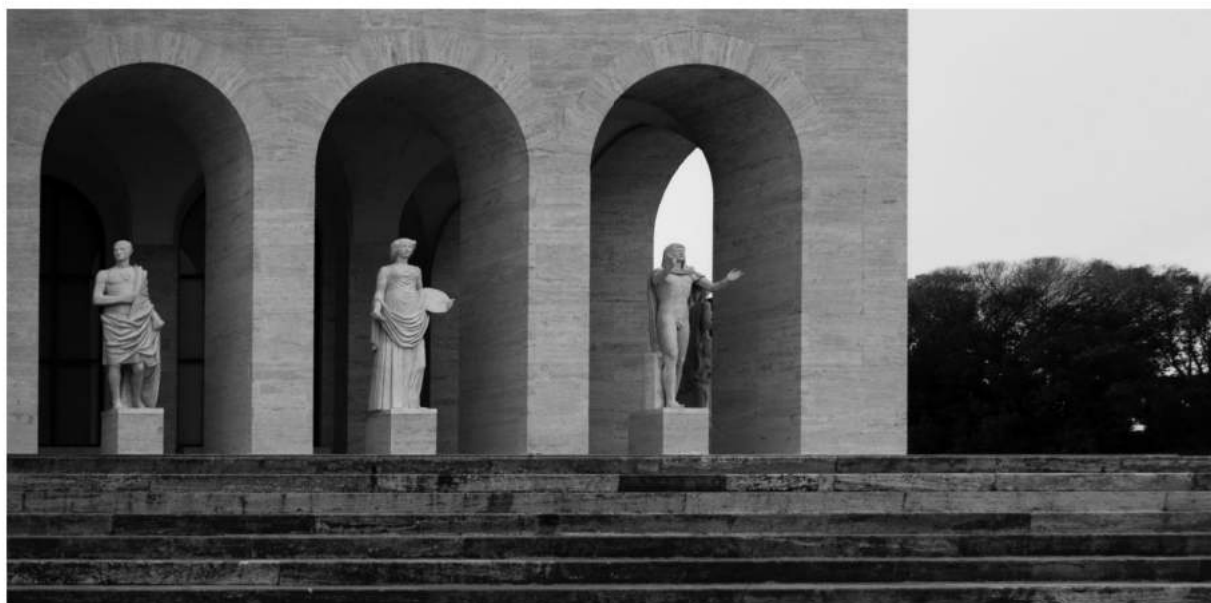
Figura5. Piano basamentale del loggiato del Palazzo della Civiltà.
