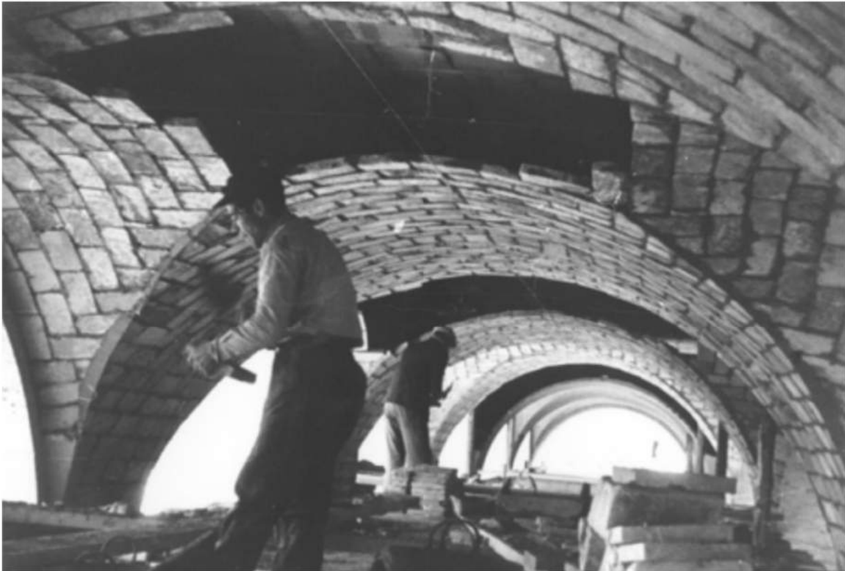
Figura3. Foto storica della realizzazione delle volte a crociera del loggiato [6].
