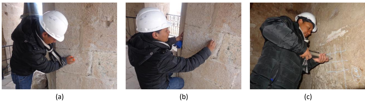
Figura 15 – Ensayo de esclerometría. (a) Preparación de la superficie de ensayo. (b) Delimitación de los puntos de ensayo. (c) Procedimiento de ensayo
