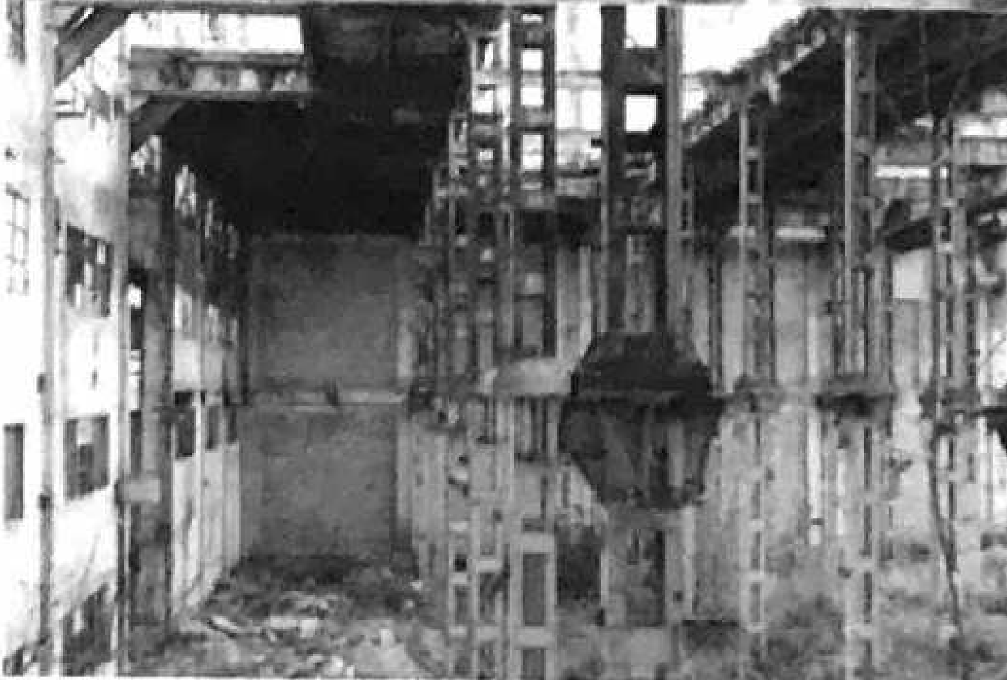
4_ Sistema costruttivo a telaio in acciaio prodotto dalla Società Italiana Ernesto Breda per Costruzioni Meccaniche del 1952 (cfr. logo pubblicitario della Società).
