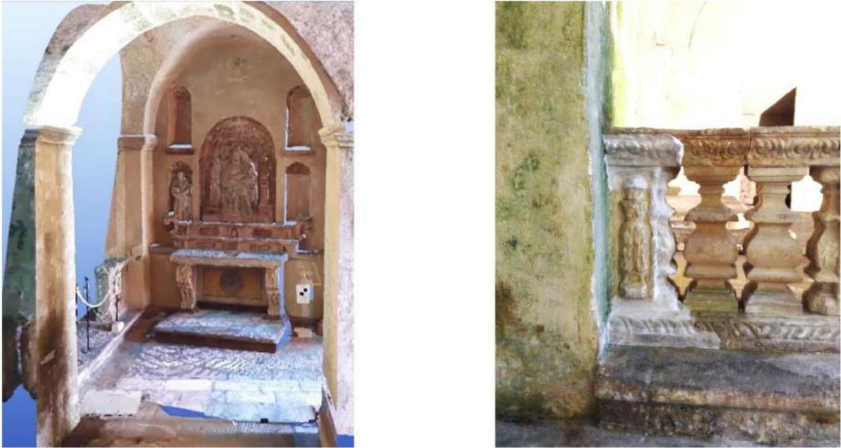
Figura8,9. A sinistra, studi di fotomodellazione della chiesa di San Pietro Barisano, a destra, saggio sperimentale di pulitura delle superfici lapidee con materiali compatibili.
