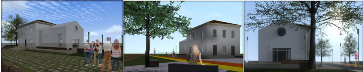
Figura 5: Viste esterne della stazione di Lauria
