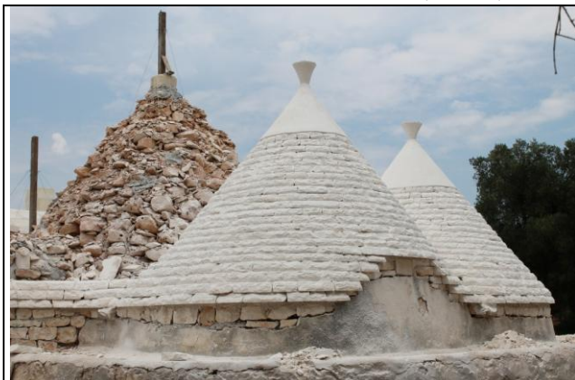
5 Restauro dei coni
