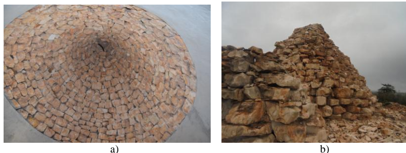
Figura 3: Cono interno (cannella) di un trullo visto a) da dentro e b) da fuori Figure 3: Inner cone (cinnamon) of a trullo seen from a) within and b) from outside
