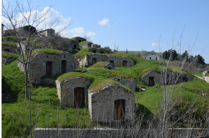
Fig. 3 - I "Palmenti" di Pietragalla (PZ), esempio di architettura rupestre del 1500.
