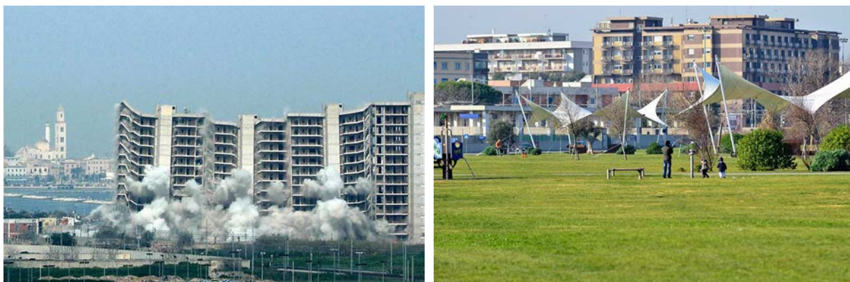
Figura 1 | Demolizione degli edifici di Punta Perotti e realizzazione del nuovo parco urbano, Bari.
