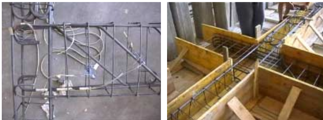
Figura 1. Dettagli delle armature e strain gauges sulla superficie delle barre longitudinali.
