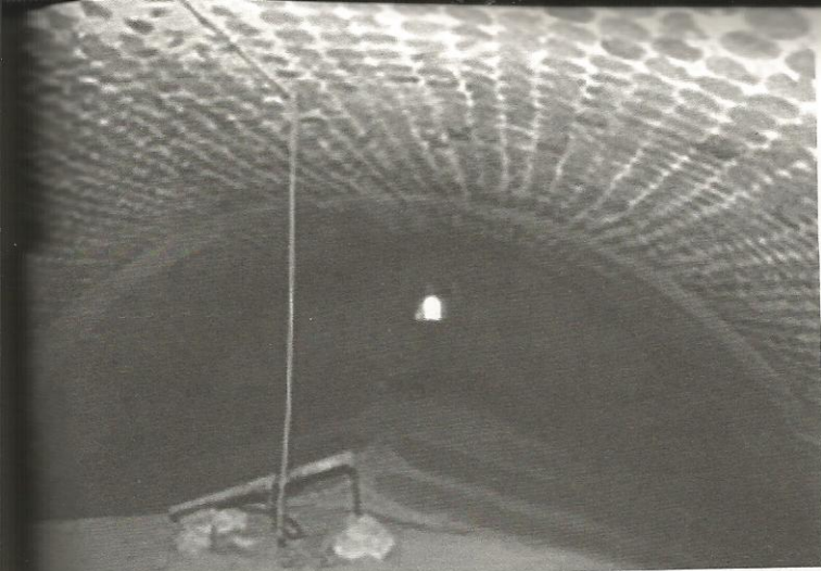
Foto del sottotetto e particolare della struttura con le "bubbole"
