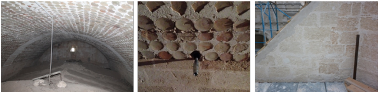
Figura 3 Foto sottotetto, particolare della struttura con le "bubbole" e tessitura dei contrafforti
