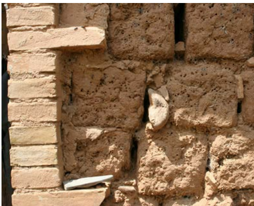
Figura 7. Alveolizzazione dei blocchi causata dalle vespe. Fonte: archivio privato Sileo Antonio - Forlenza Giovanna.
