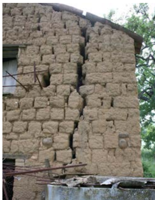
Figura 6. Dissesto prodotto da evento sismico. Fonte: archivio privato Sileo Antonio - Forlenza Giovanna.
