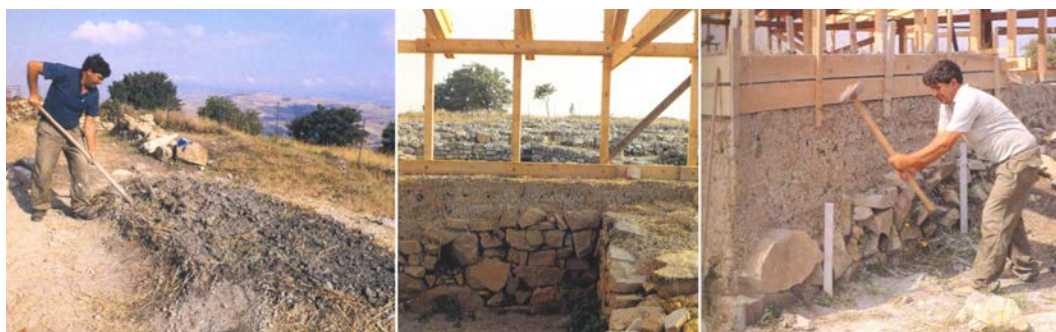
Figura 3. Fasi costruttive della «Casa dei Pithoi» a Serra di Vaglio – Vaglio Basilicata (Potenza) – in Basilicata. Da sinistra la vasca d'impasto dell'argilla sgrassata con paglia, e la posa in opera sulle fondamenta in pietra, del V secolo a. C., del detto impasto con l'ausilio di casseri in legno. Fonte: GRECO GIOVANNA (a cura di). Serra di Vaglio, cit., pp. 59 ssg.
