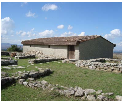
Figura 2. La «Casa dei Pithoi» a Serra di Vaglio – Vaglio Basilicata (Potenza) – in Basilicata. Si tratta della ricostruzione in terra cruda "com'era e dov'era" di un edificio abitativo risalente al V secolo a.C. all'interno dell'area della città fortificata (VIII secolo a. C. – III secolo a.C.).
