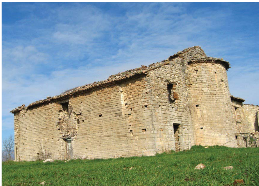
Fig. 7. San Pietro di Cellaria (Calvello). Il complesso visto da sud-est, in primo piano l'abside e l'ala meridionale
