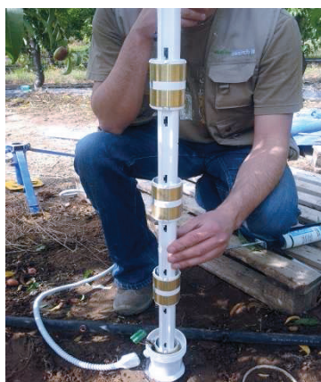
Figura 3. Particolare dell'installazione della sonda Enviroscan "senteck"
