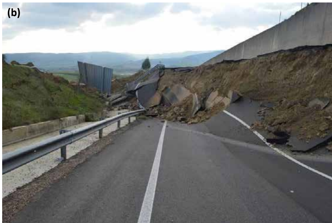
Figura 12: a) Foto aerea, scattata il giorno 4 dicembre 2013, che evidenzia una grande frattura (freccie rosse più grandi), con un dislocamento di circa 8 – 10 m in altezza; b) Danneggiamento della nuova arteria di accesso al paese.
