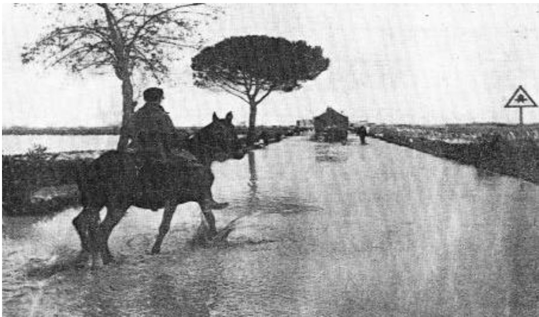
Figura 5: SS 106 invasa dall'acqua a seguito dell'esonazione del fiume Basento (da "Basilicata" del 29/11/59).
