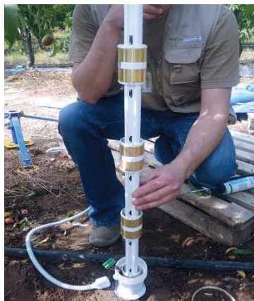
Figura 3. Particolare dell'installazione della sonda Enviroscan "senteck"
