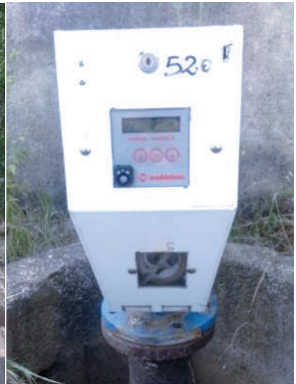
Figura 1. La rottamazione impianti irrigui è stata sostenuta in Basilicata con una misura dedicata (DGR 2059/2001). Si noti la presenza dell'impianto irriguo sovrachioma sostituito con quello localizzato (tubi in PVC); Sostituzione delle vecchie bocchette di erogazione (sinistra) con nuovi erogatori (destra) che consentono la contabilizzazione dei volumi irrigui prelevati operata in Consorzi irrigui della Basilicata (Tratto da Xiloyannis et al., 2015)
