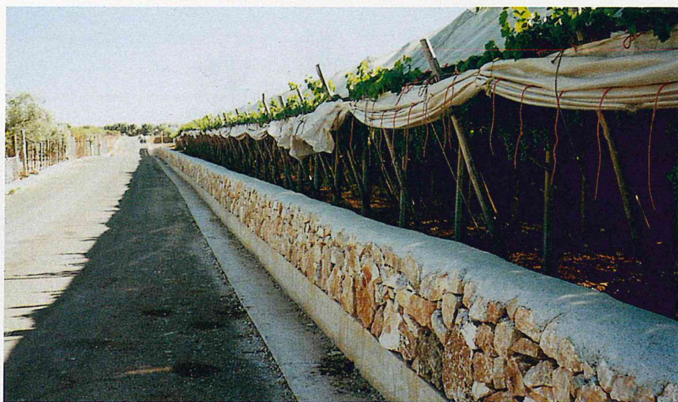
Fig. 1 - Allevamenti a tendone per uva da tavola sulla strada n. 1 - via Turi.
