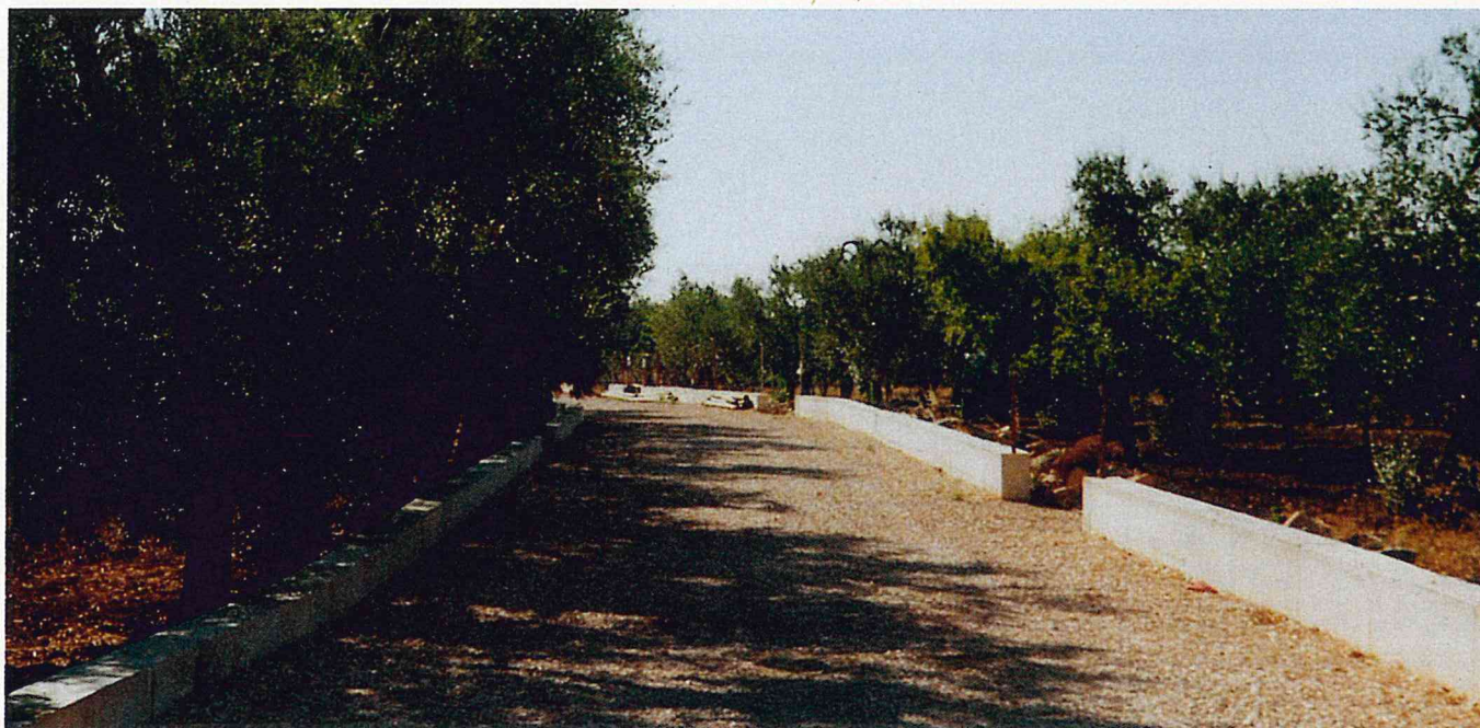
Fig. 7 - Fondazione in cemento armato del muro laterale di contenimento in fase di realizzazione.
