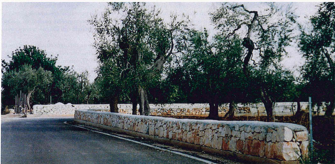
Fig. 8 - Muro a secco con soletta di ripartizione in cls debolmente armato.
