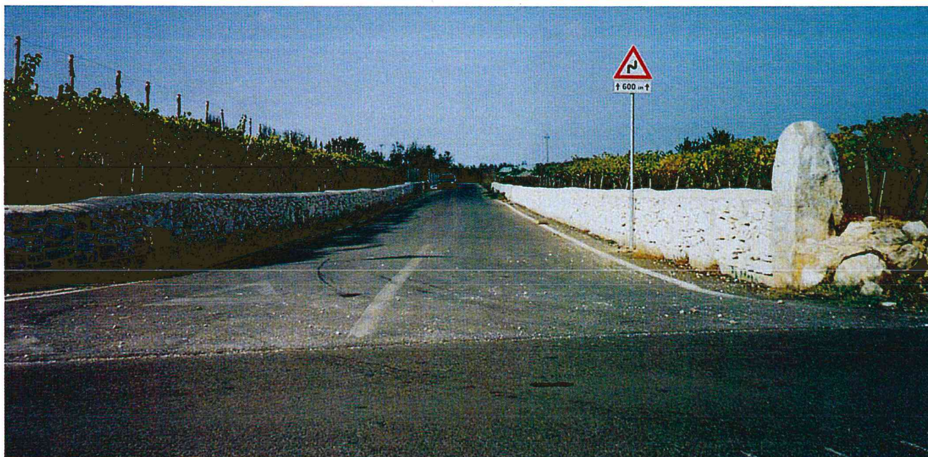
Fig. 9 - Imbocco della strada n. 13 - via Capacci dopo l'intervento di sistemazione ed ammodernamento.
