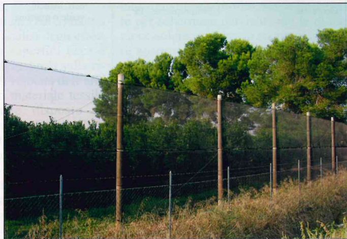
Fig. 2 - Reti impiegate per protezione frangivento.
