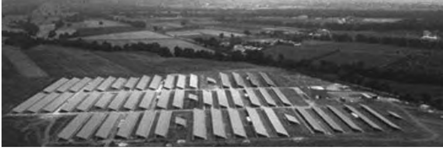
Fig. 1 - The PV array Serre-Persian (Salerno)
