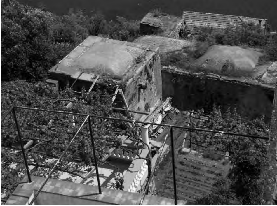
Fig. 7 - Vaults in Conca dei Marini
