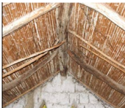
Fig. 6. Particolare facciata interna di tetto in cannuce e argilla.
