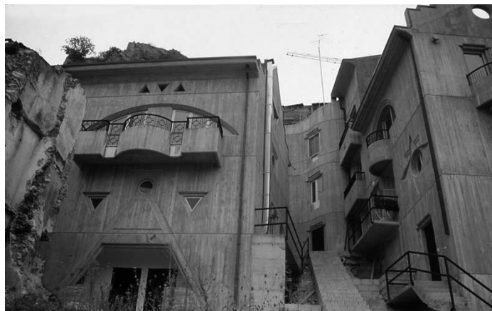
Figura 6 - Nuove tipologie edilizie inserite nella zona storica disastrosa - Balvano
