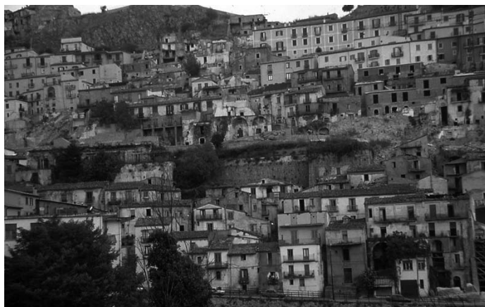
Figura 14 - La zona centrale di Muro Lucano fortemente danneggiata dal sisma e interessata da interventi di demolizione e non ricostruzione con la realizzazione di interventi di adeguamento viario per migliorare l'accessibilità veicolare al centro storico
