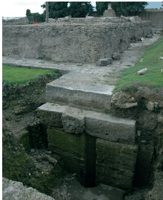
Fig. 12. Vista da sud delle fondazioni e del podio flavio (Foto Curti).
