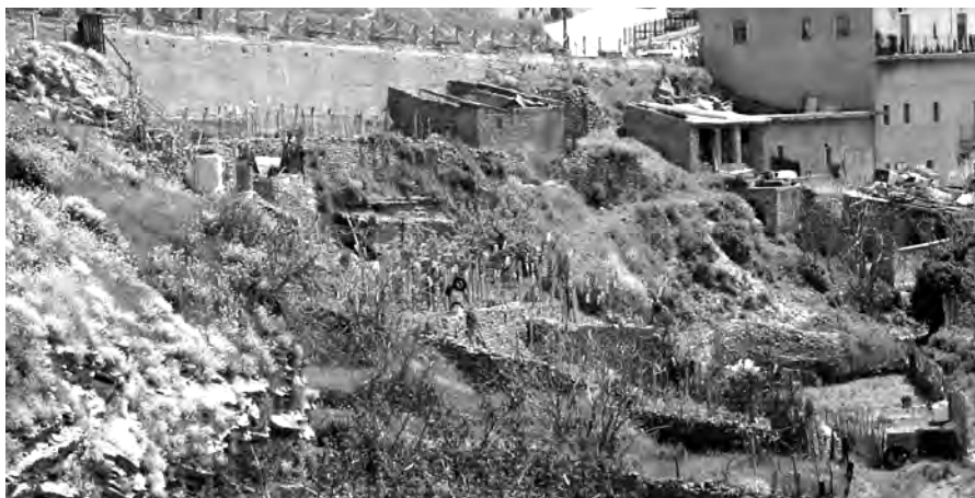
Fig. 6 – gli Orti Saraceni. In rilevanza il generale stato di abbandono dell'area
