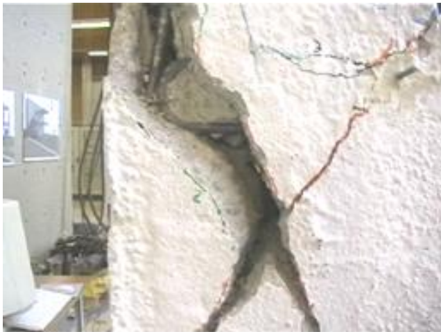
Figura 4. a) Nodo esterno T23 e b) particolare del quadro fessurativo del pannello nodale a fine prova
