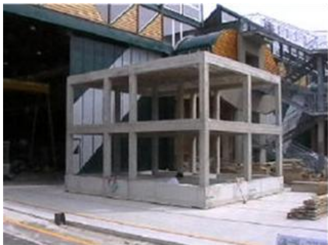
Figura 1. Struttura in scala 2:3 da sperimentare presso il DiSSG dell'Università degli Studi della Basilicata
