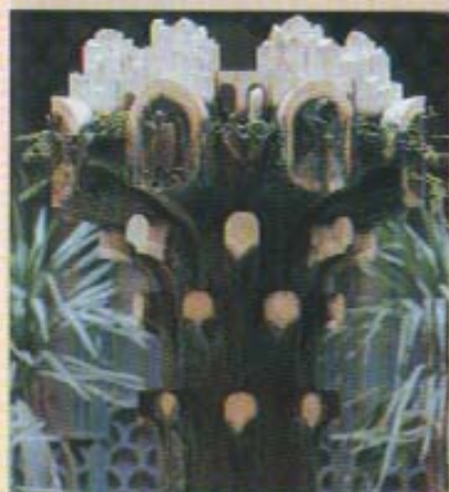
Fig. 30 Palazzo dell'Acquedotto Pugliese, anno, particolare della fontana con gli stemmi delle città pugliesi.
