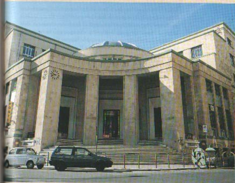
Fig. 53 Edificio sede Poste Centrali
