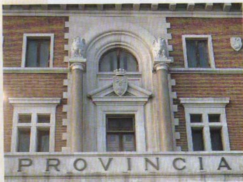
Fig. 12 Palazzo della Provincia, particolare della facciata
