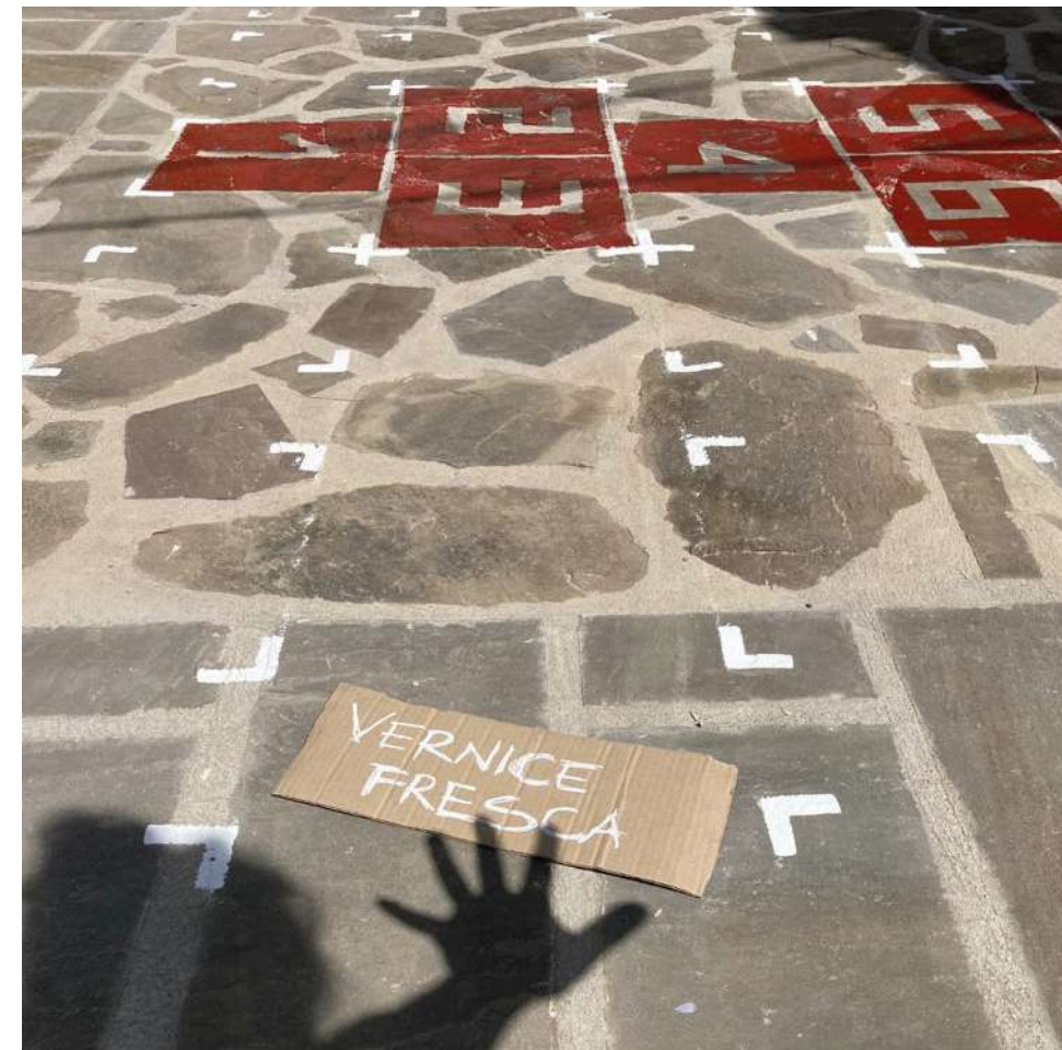
Fig. 9: Lavori in corso - Convivium Park San Severino Lucano.
