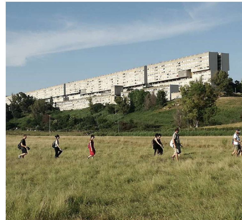
Fig. 2: Vista dell'edificio principale del Piano di Zona Corviale durante un'esplorazione urbana.
